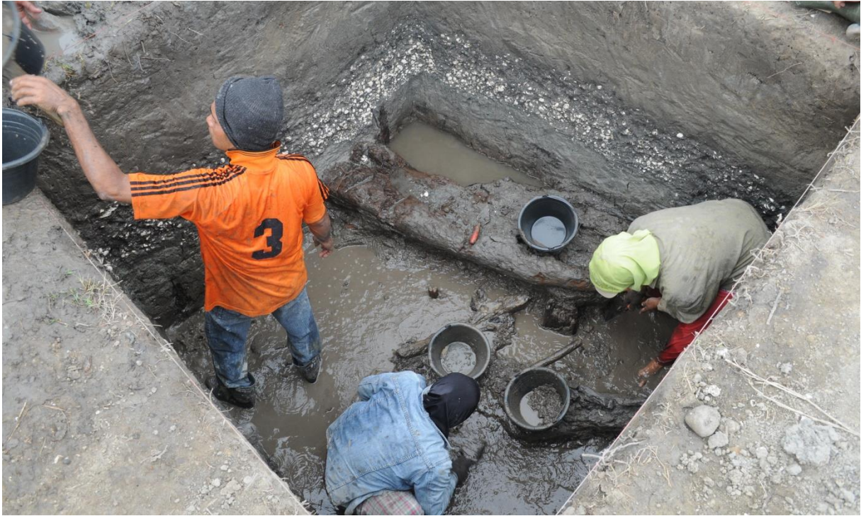
Figure 2.37 - Dégagement de vestiges de débarcadère en zone A (Cliché : D. Perret, 2016).
