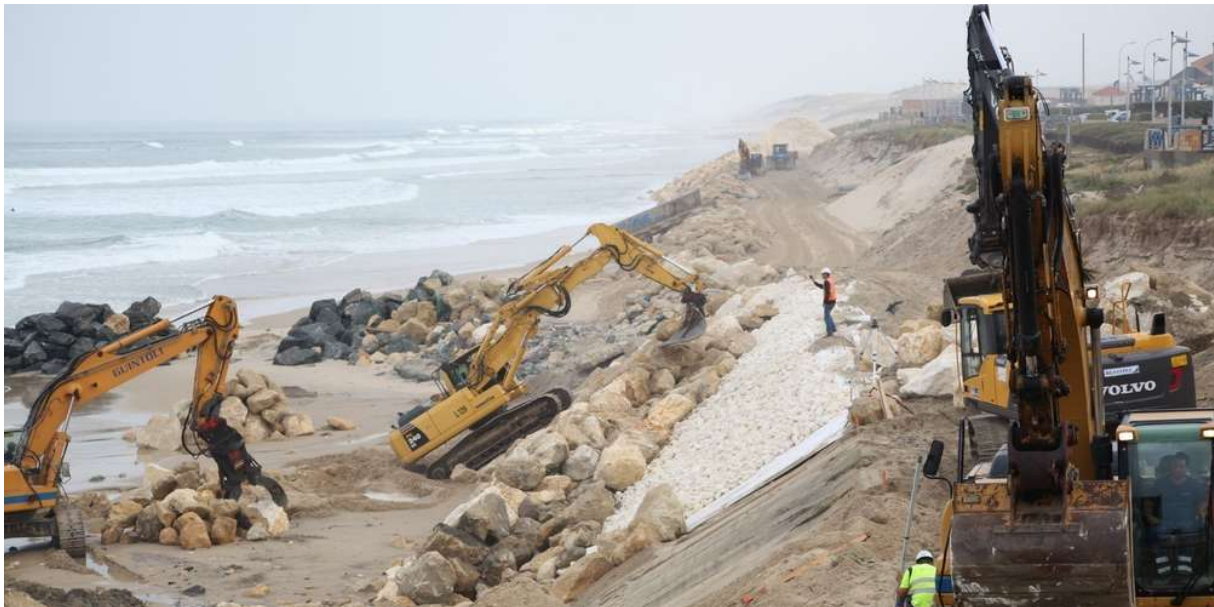
Figure 24 : Travaux de reconstruction des défenses du front de mer à Lacanau-Océan au printemps 2014 (Source : Sud-Ouest)
