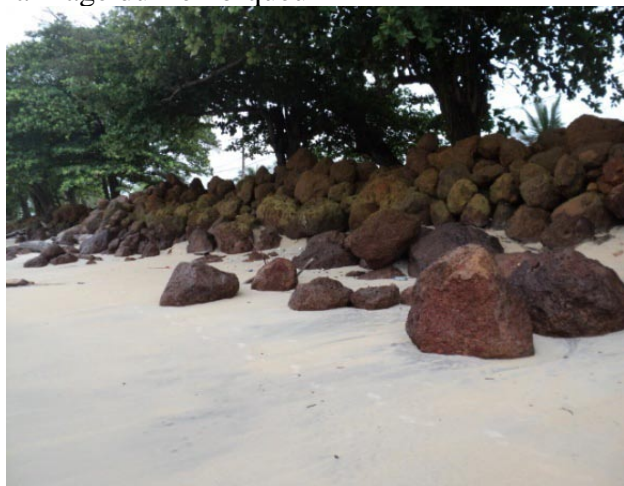
Photo 24: Cordon d'enrochement latéritique à la Plage du Remorqueur
