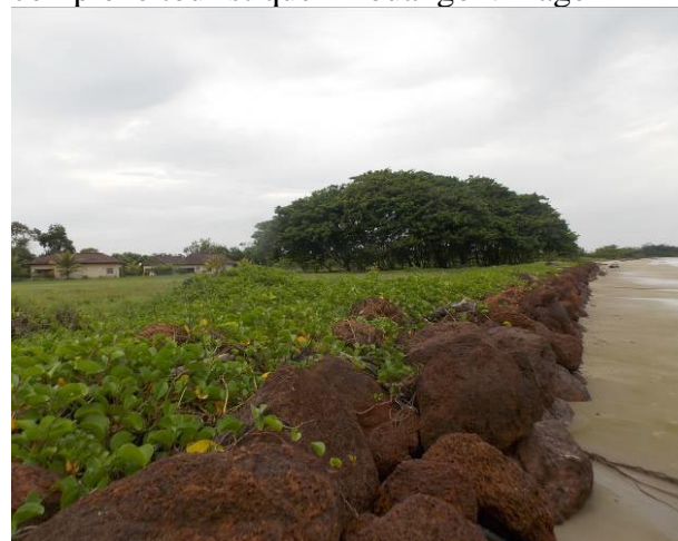
Photo 25: Cordon d'enrochement latéritique au complexe touristique Akouango Village
