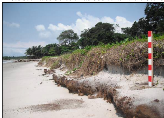
Photo 35: Talus d'érosion au Sud de la rivière Otendé
