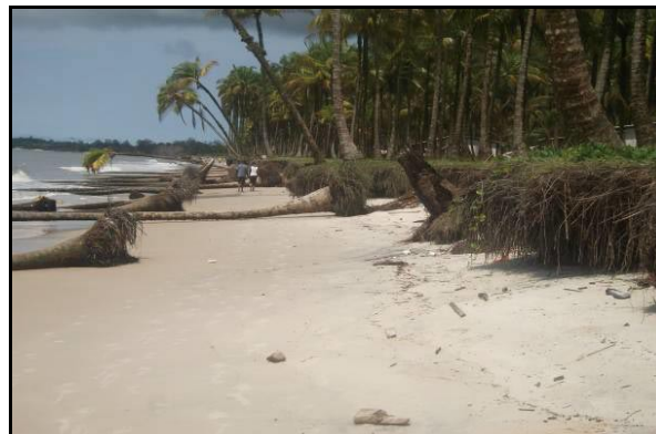
Photo 38: Cocotiers détruits par l'érosion côtière à La Cocoteraie
