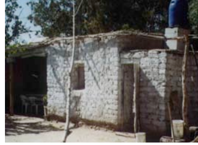
Figure 1. 7 : Maison typique en adobe, Argentine [Blondet et M., 2005].
