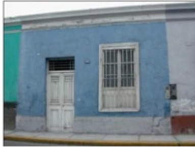
Figure 1. 6 : Maison typique en adobe, Perou [Blondet et M., 2005].
