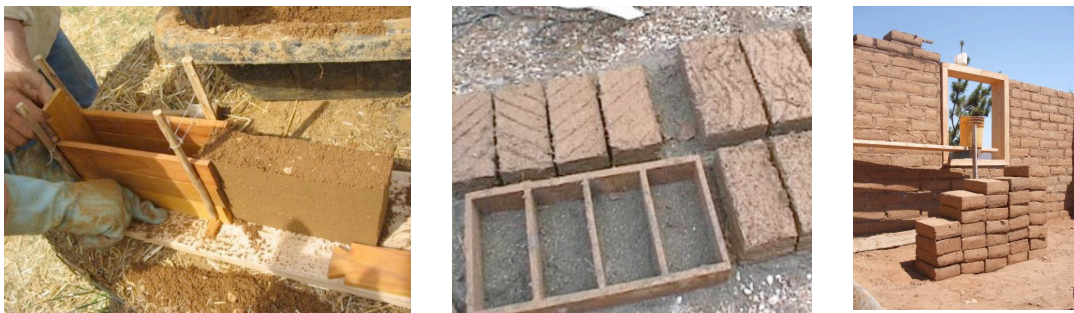
Figure 1. 5 : (a) et (b) Technique de fabrication de l'adobe ; (c) Maison en adobe en construction [Hibouche, 2013].
