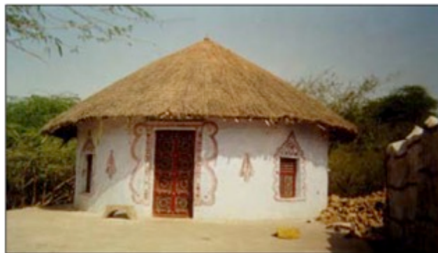
Figure 1. 8 : Maison typique en adobe, Inde [Blondet et M., 2005].
