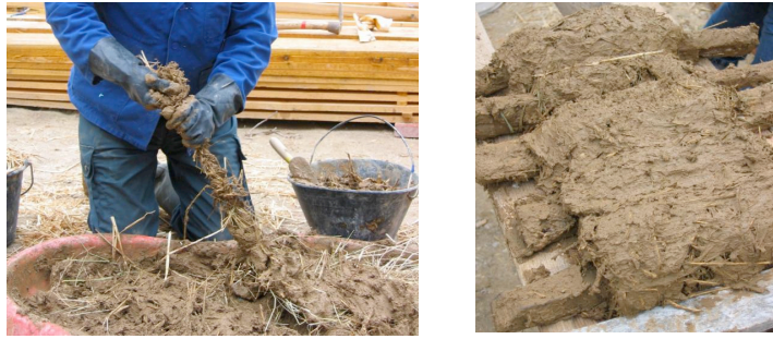
Figure 1. 11 : Préparation de torchis [Marchal - Maisons Paysannes de France].
