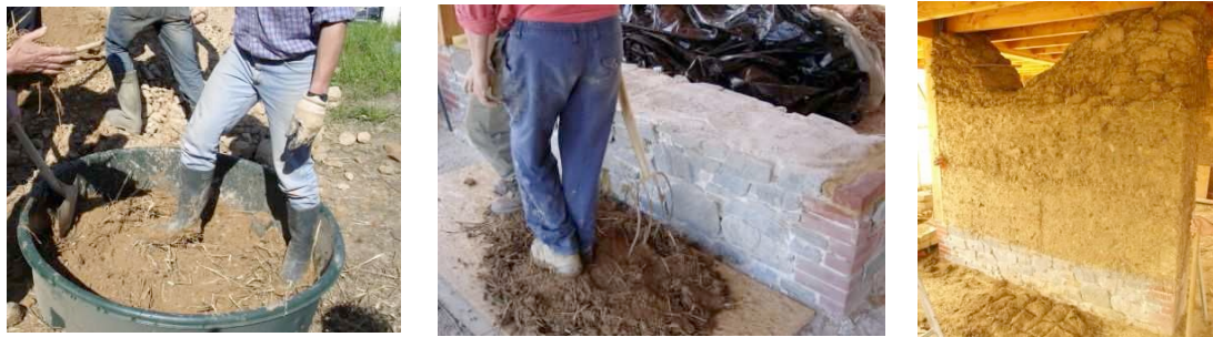
Figure 1. 9 : Construction d'un mur en bauge. [ http://empreinte.asso.fr/la-bauge ].
