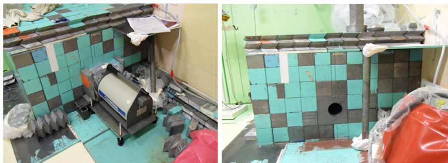
Figure 6-8 : Solutions provisoire (à gauche) et définitive (à droite) pour la reconstitution de la paroi de l'enceinte
