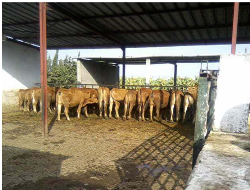
Figure 1. Exemple de bâtiment ouvert avec toiture métallique dans la région de Bizerte
