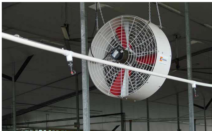
Figure 16. Système d'aspersion avec ventilateurs proposé par le site Ontario.ca (2015)
