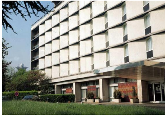
FIGURE 37 PHOTO D'UN IMMEUBLE (EXEMPLE TIRE DE LA DOCUMENTATION D'OPENCV 13 )
