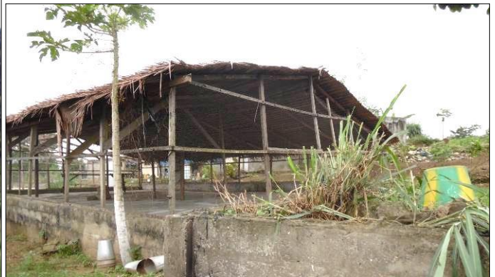
Photo 4 : Un bâtiment avicole d'une capacité de 10 000 poulets de chair inexploité à Akouai Santé à Bingerville
