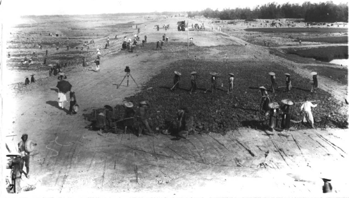
Figure 5.3 : Travaux d'entretien d'une digue près de Hanoi au début du 20 ème siècle
