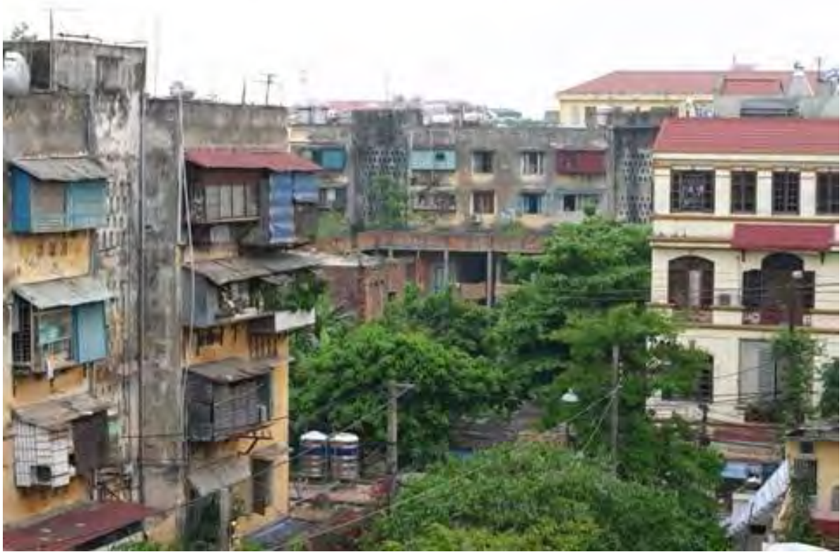
Figure 6.17 : Le logement collectif F361 du quartier Phuc Xa de nos jours
