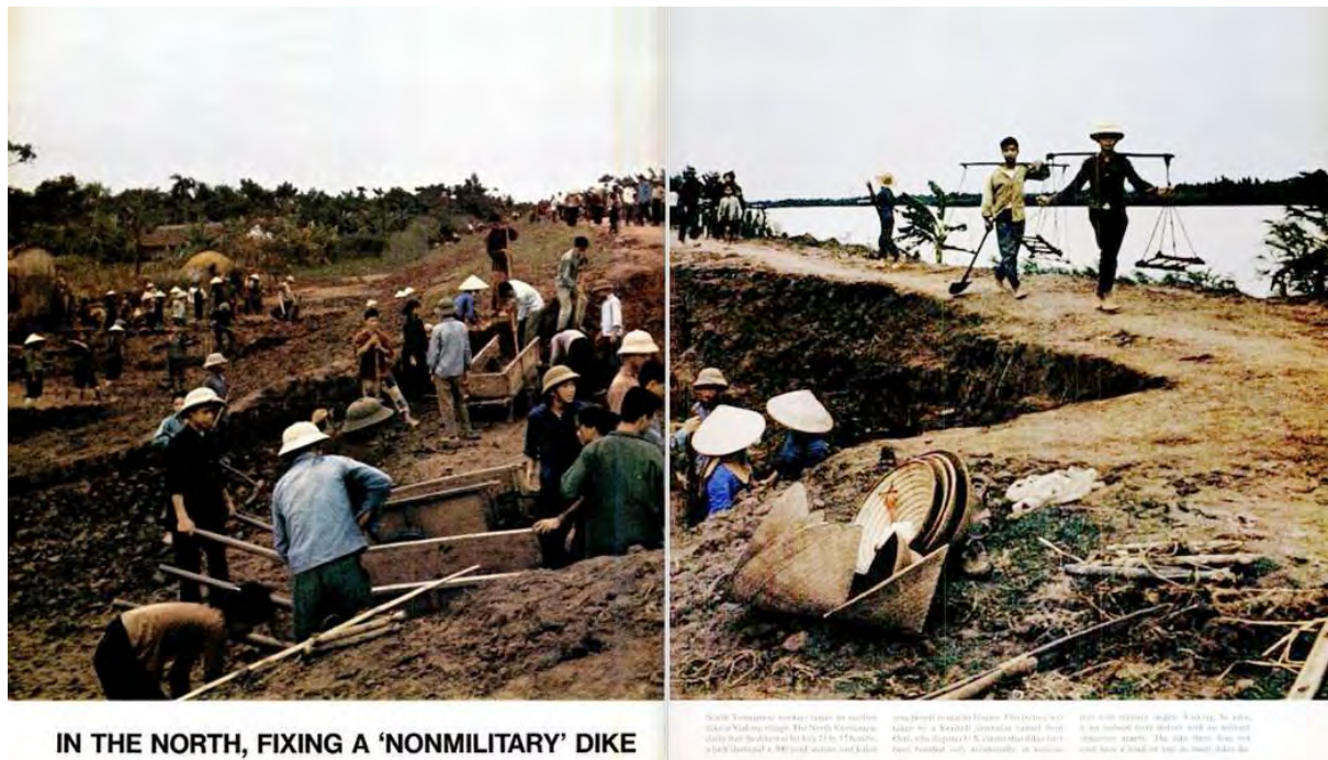
Figure 2.24 : Les vietnamiens réparent une partie de la digue bombardée au village Vu Bang, province Nam Dinh en 1972
