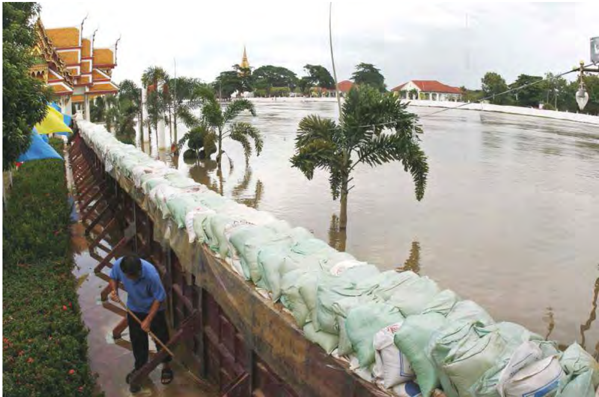
Figure 1.9 : Un homme est en train de consolider une partie de digue sur le fleuve Chao Phraya
