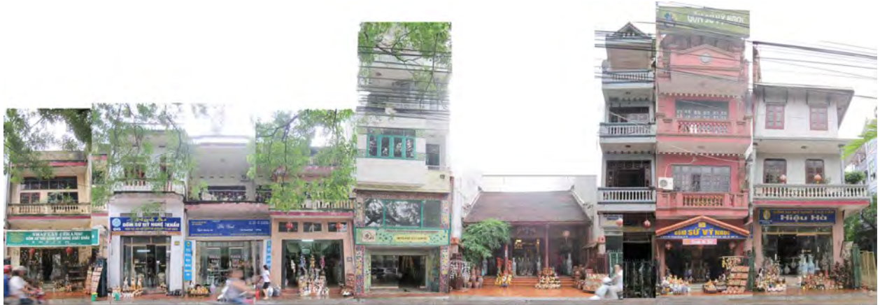
Figure 8.42 : Les façades des maisons dans l'axe commercial
