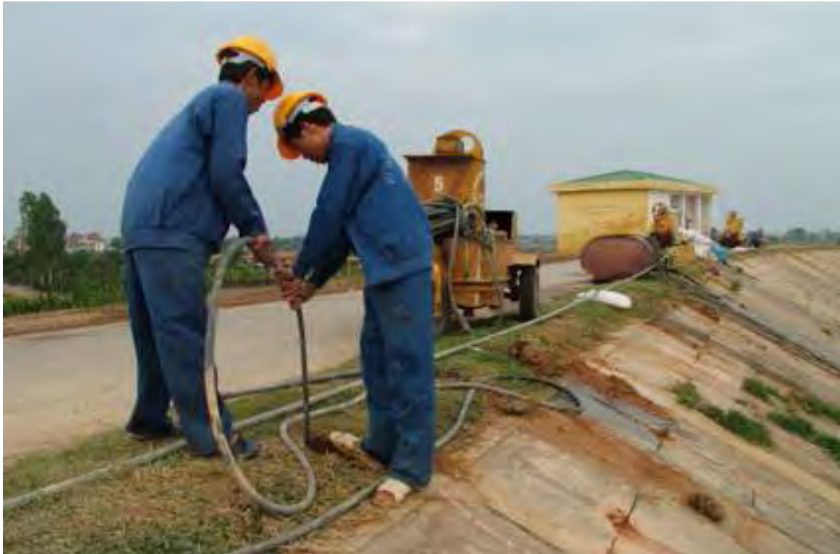
Figure 9.20 : La maintenance régulière de la digue
