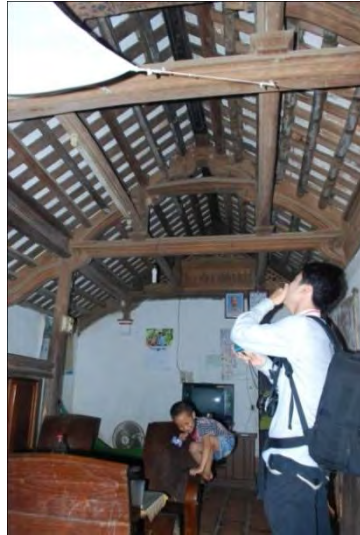
Figure 3.15 +3.16 : La structure en bois des maisons traditionnelles Enquête de terrain en 2011
