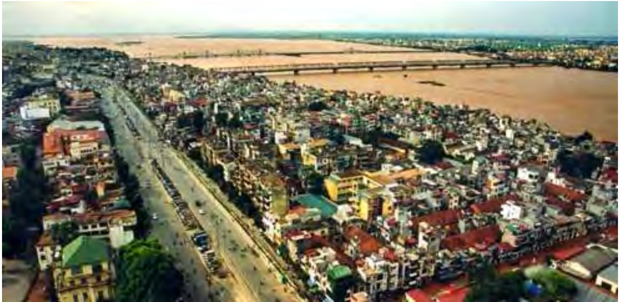
Figure 5.5 : La vue aérienne de la construction dans les zones hors digue
