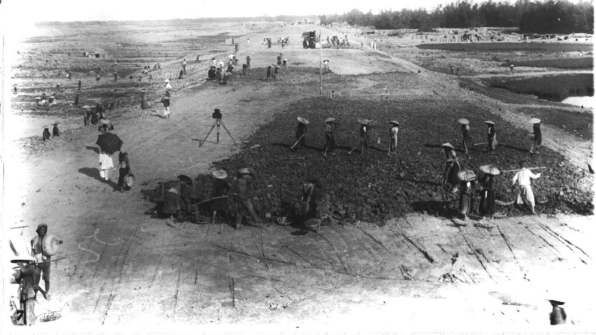
Figure 5.3 : Travaux d'entretien d'une digue près de Hanoi au début du 20 ème siècle
