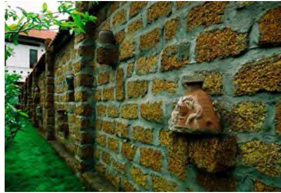
Figure 3.17 + 3.18 : Les murs en latérite du village Duong Lam - Hanoi Source: http://thanglong.ictnews.vn
