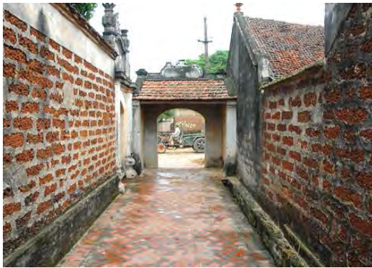
Figure 3.17 + 3.18 : Les murs en latérite du village Duong Lam - Hanoi Source: http://thanglong.ictnews.vn
