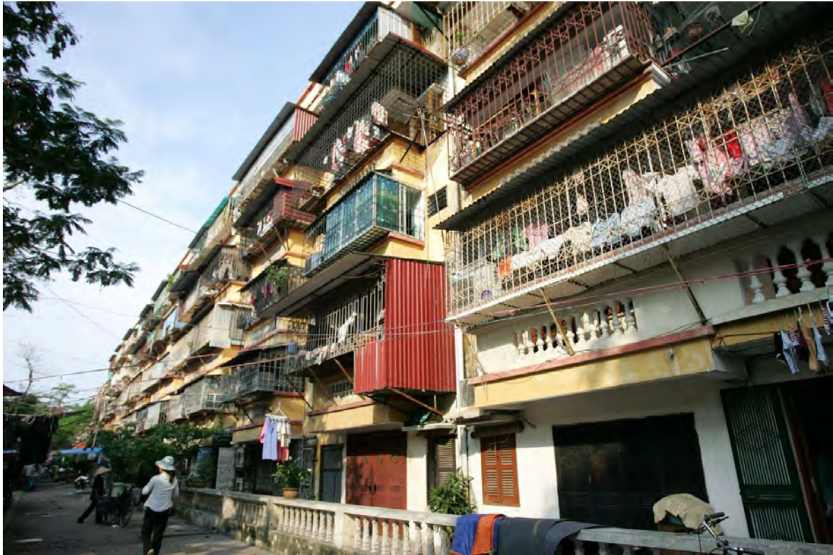
Figure 4.8 : Un immeuble collectif typique de Hanoï
