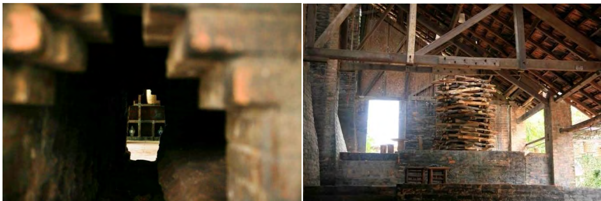
Figure 8.11 + 8.12 : La petite porte dans chaque chambre de combustion et le bois pour la cuisson Source : enquête de terrain 2015
