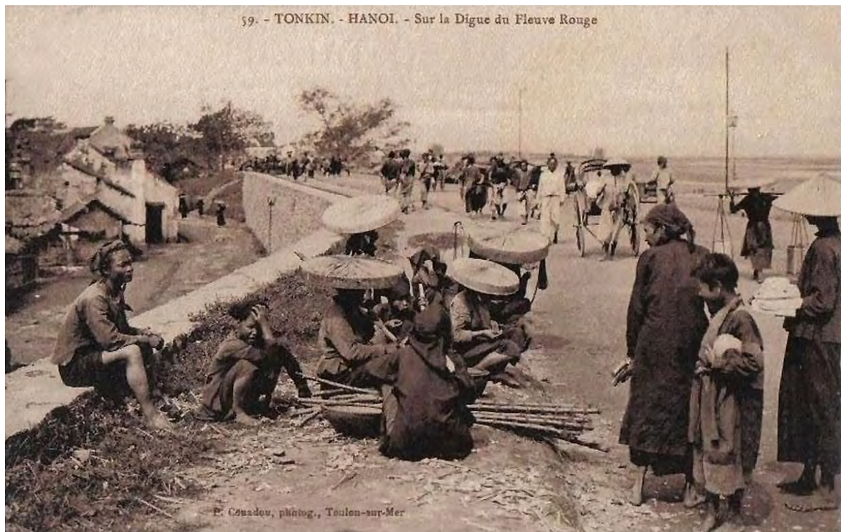
Figure 3.27 : Les échanges économiques sur la digue au début du XXème siècle
