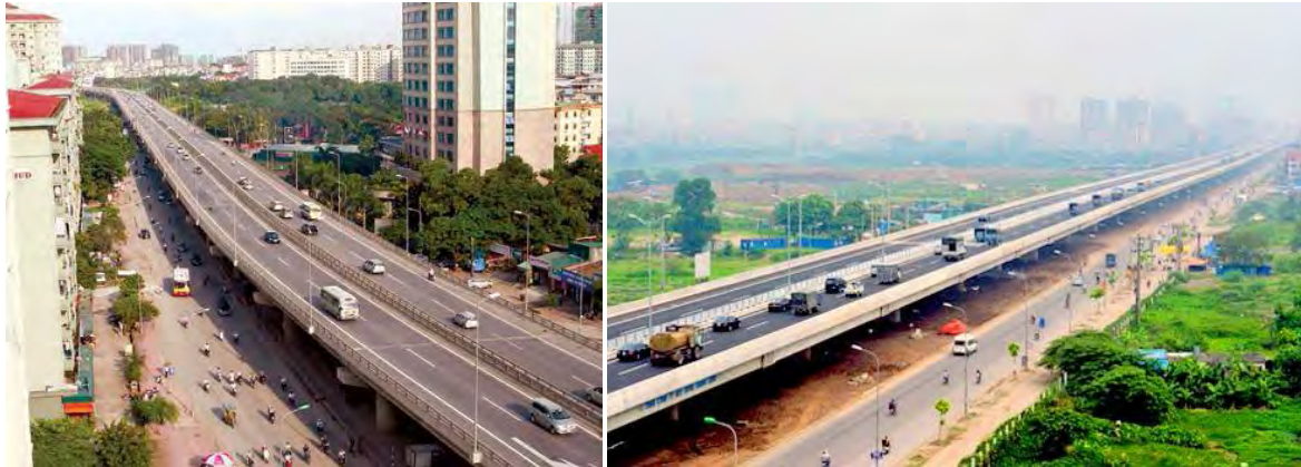
Figure 3.29 + 3.30 : Route de la troisième périphérie ( đường vành đai 3 ) de Hanoi qui traverse l'arrondissement Hoang Mai et le district Thanh Tri
