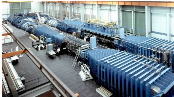
FIG. 5.1 – Vue de dessus du Grand Tunnel Hydrodynamique (GTH).
