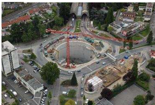
Figure B-2. Bassin Jenner –Le Havre- (site de l'entreprise Quille-Construction)
