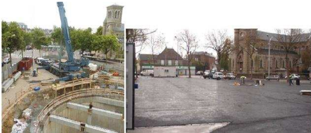
Figure B-3. Vue générale du bassin du Docteur Leveque –Le Havre- pendant les travaux et après la remise en état (site de l'entreprise Quille-Construction)
