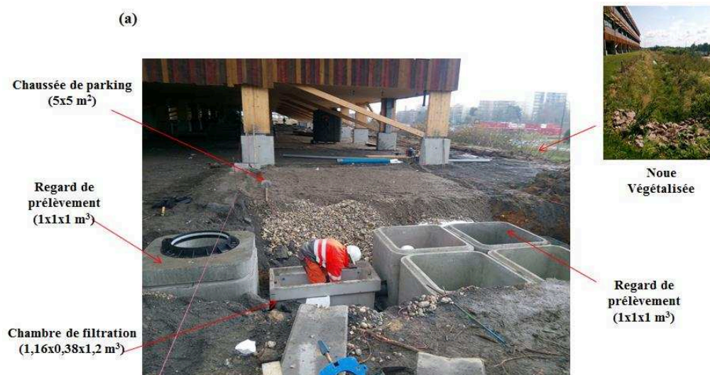
Figure F-2. Dispositif de filtration pendant la réalisation
