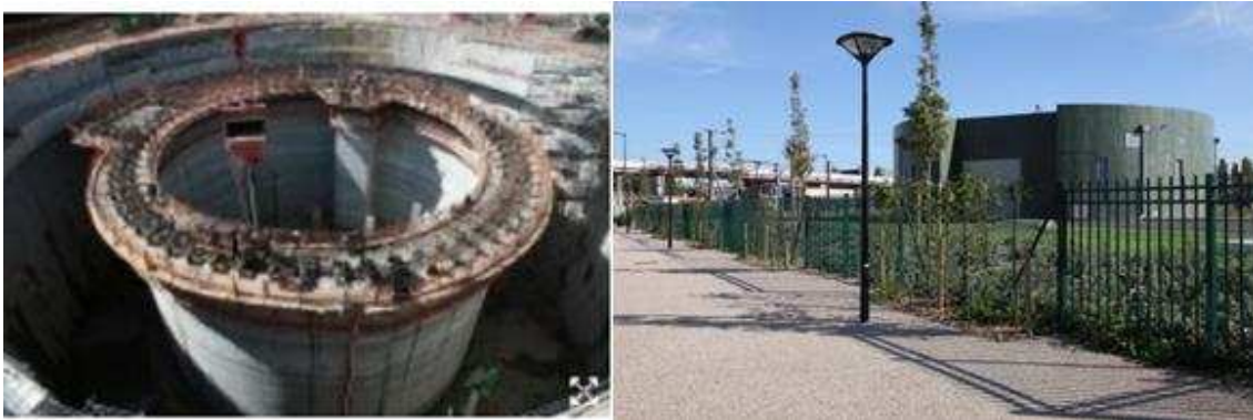
Figure B-1. Bassin Demidoff –Le Havre- pendant et après la fin des travaux ( site de l'entreprise Quille-Construction )
