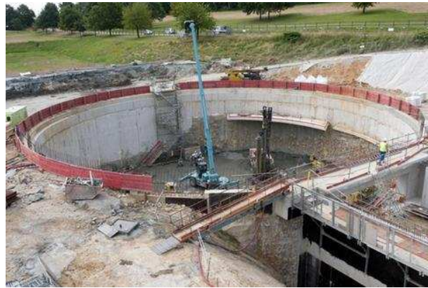
Figure B-4. Chantier du bassin de stockage Harquebosc - Harfleur (Sefi-Intrafor ; 2013)
