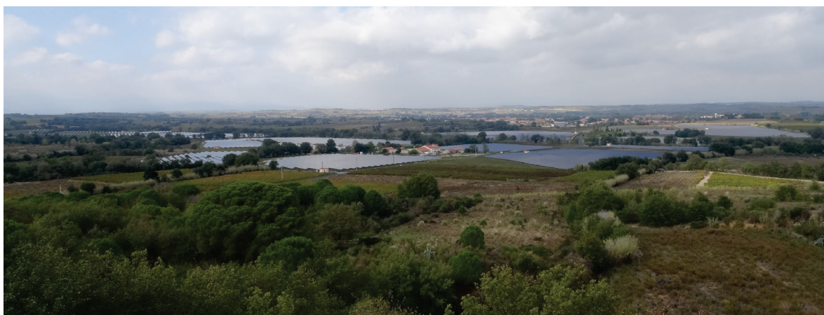
Illustration 10 : La centrale photovoltaïque d'Ortaffa en Novembre 2016
