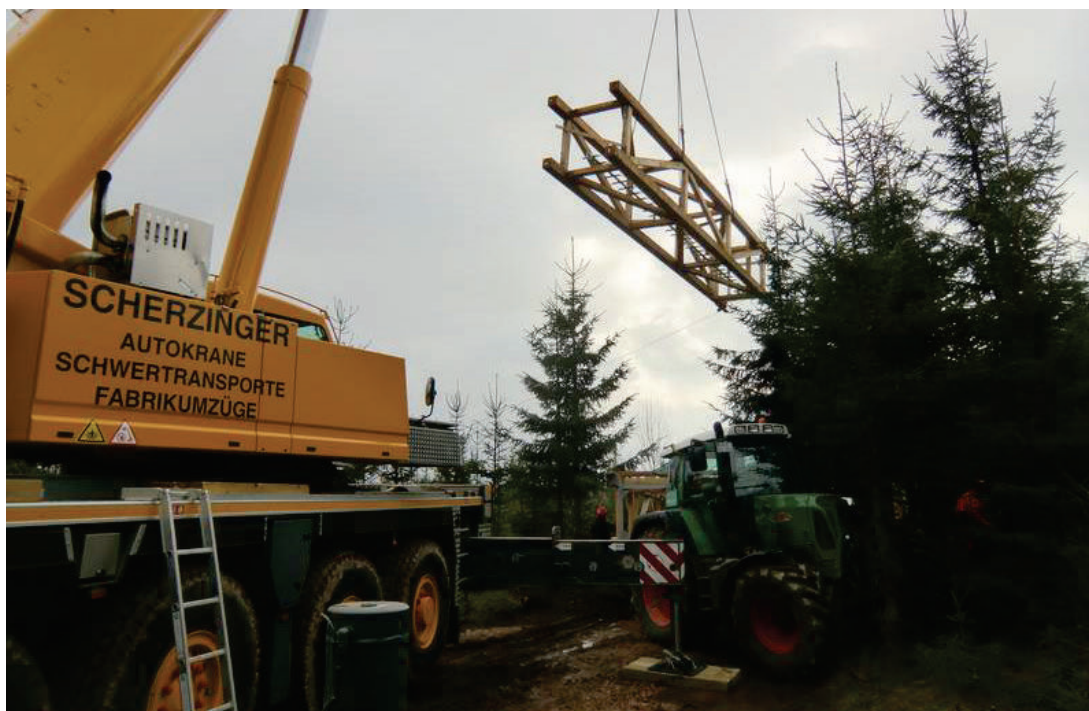
Illustration 25 : L'installation collective du mât de mesure en bois à Linach dans la Forêt-Noire en 2013
