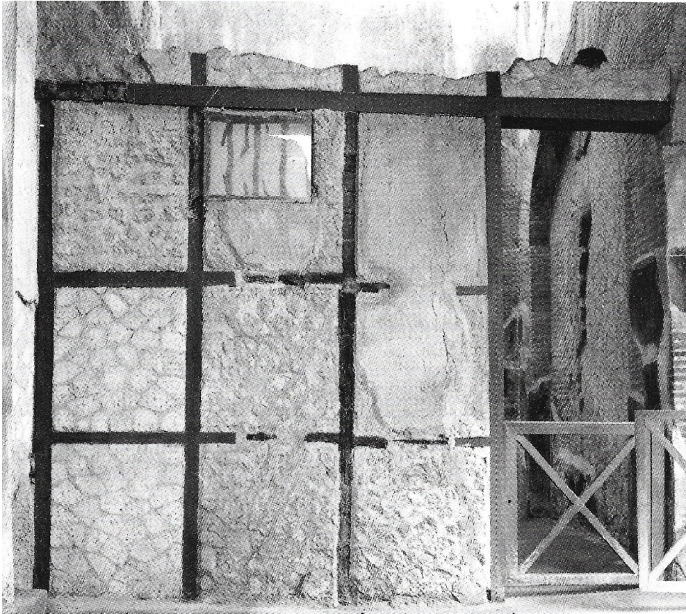
Fig. 20 : Cloison en pan de bois à Herculenum (extrait de Adam 1984, p. 133).
