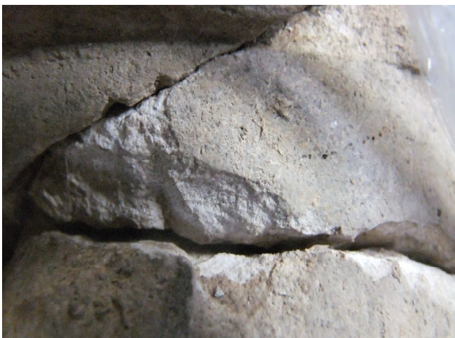
Fig. 268 : Référentiel pétrographique des matériaux de construction lithiques à Selongey « Les Tuillières ». a) complexe calcaire récifal (cliché : F. Delencre 2016) ; b) Pierre de Ladoix (cliché : F. Delencre 2016) ; c) Pierre d'Asnières (cliché : F. Delencre 2016).
