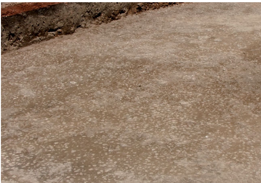
Fig. 191 : Détail du sol de circulation de l'espace 5 constitué de blocs de Calcaire à gryphées arquées concassés (cliché : F. Delencre 2011).
