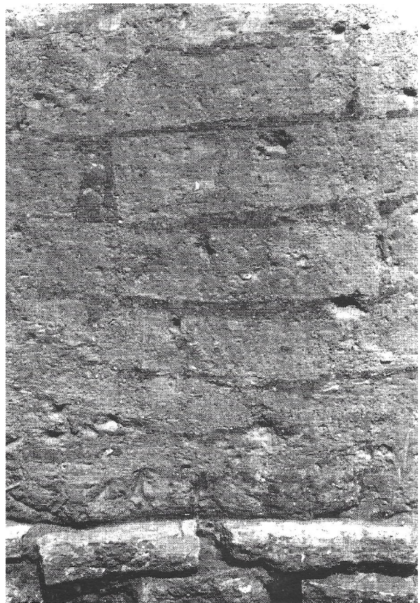
Fig. 22 : Modes de construction en terre crue. a) Vestiges d'un mur en bauge à Saint-Pierre-lès-Martigues (extrait de De Chazelles-Gazzal 1997, p. 85) ; b) Mur de pisé contemporain à Villars-lès-Dombes (extrait de De Chazelles-Gazzal 1997, p. 108) ; c) Mur de briques crues à Saint-Pierre-lès-Martigues (extrait de De Chazelles-Gazzal 1997, p. 77).
