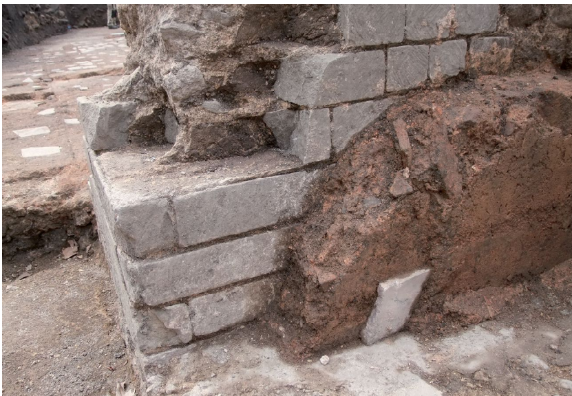
Fig. 190 : Moellons en Grès blond du Rhétien constituant le piédroit d'une ouverture (cliché : F. Delencre 2011).
