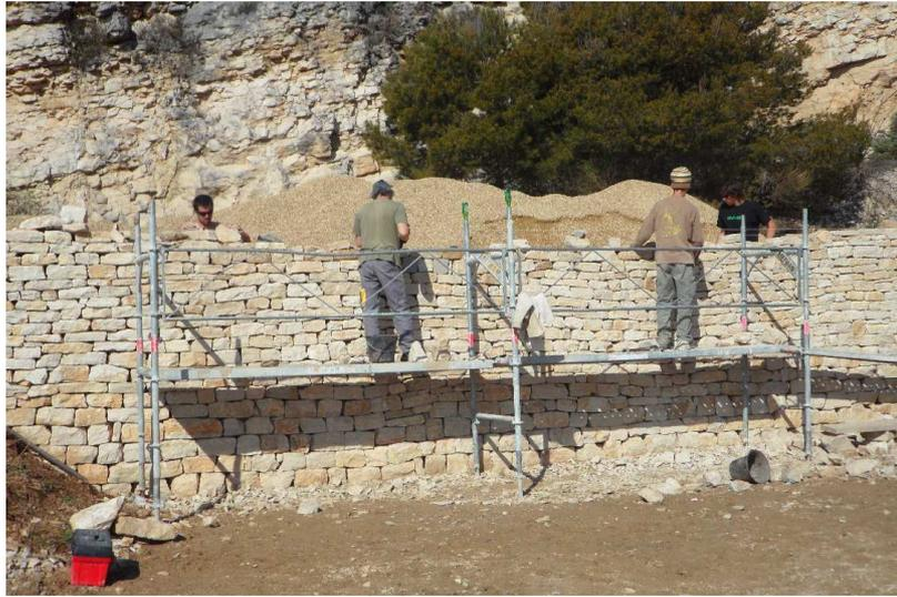
Figure 1.25 – Construction d’un des murs testé par Le (2013).
