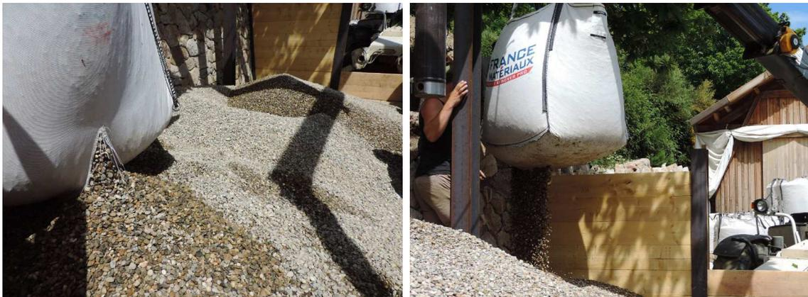
Figure 4.24 – Mise en place du remblai.
