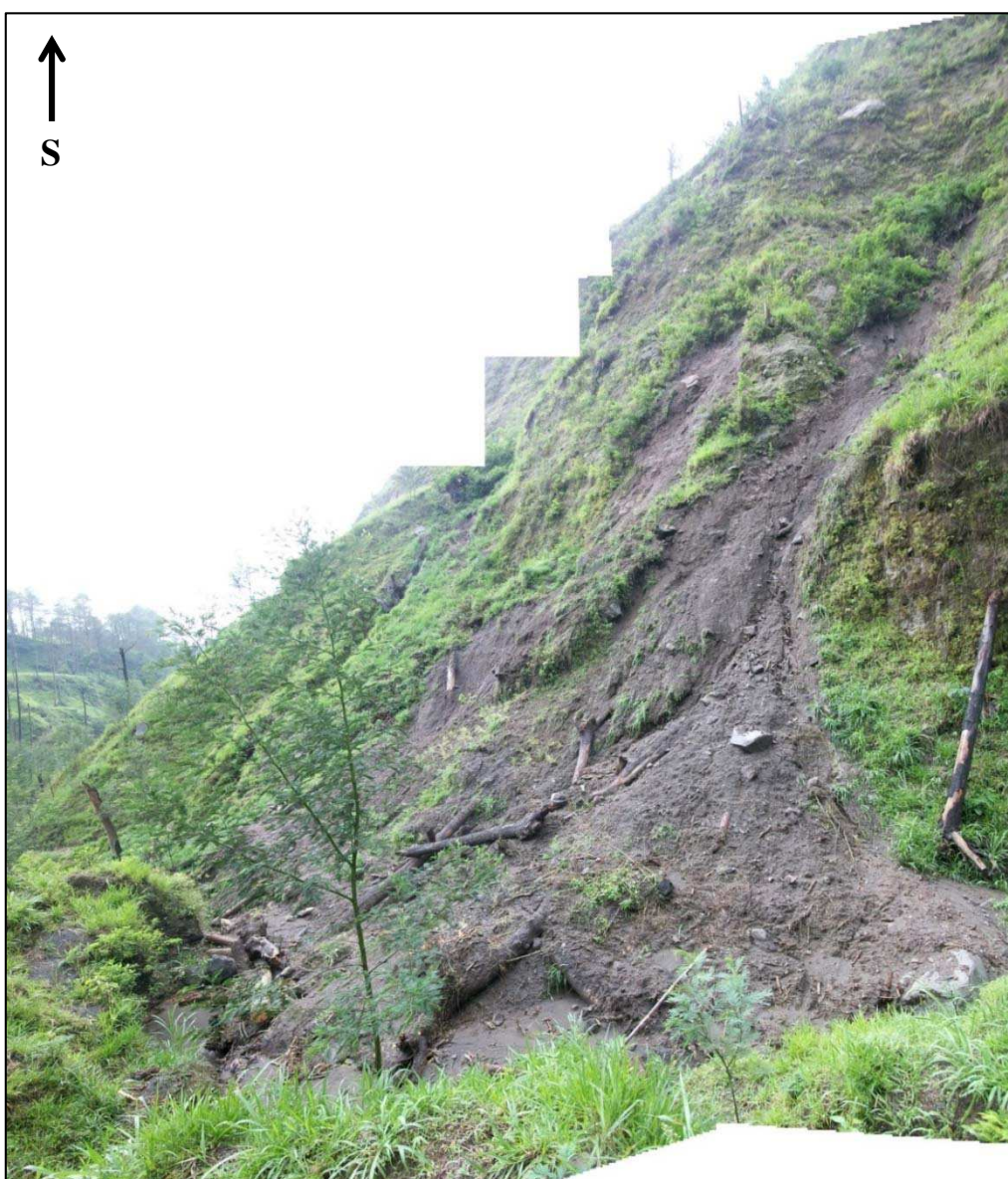
Figure 27 - Glissement de terrain après la pluie du 6 décembre 2012.
