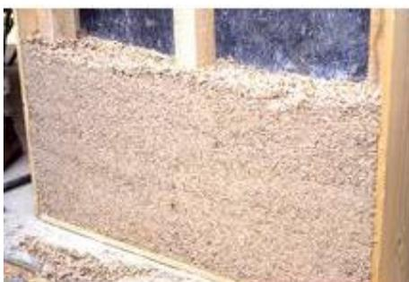
Figure I-9: Procédé de mise en œuvre par banchage
