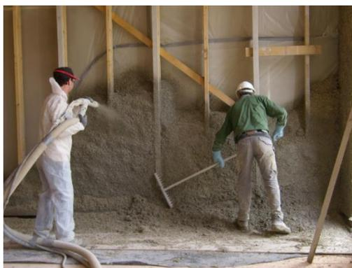
Figure I-10: Procède de mise en œuvre par projection
