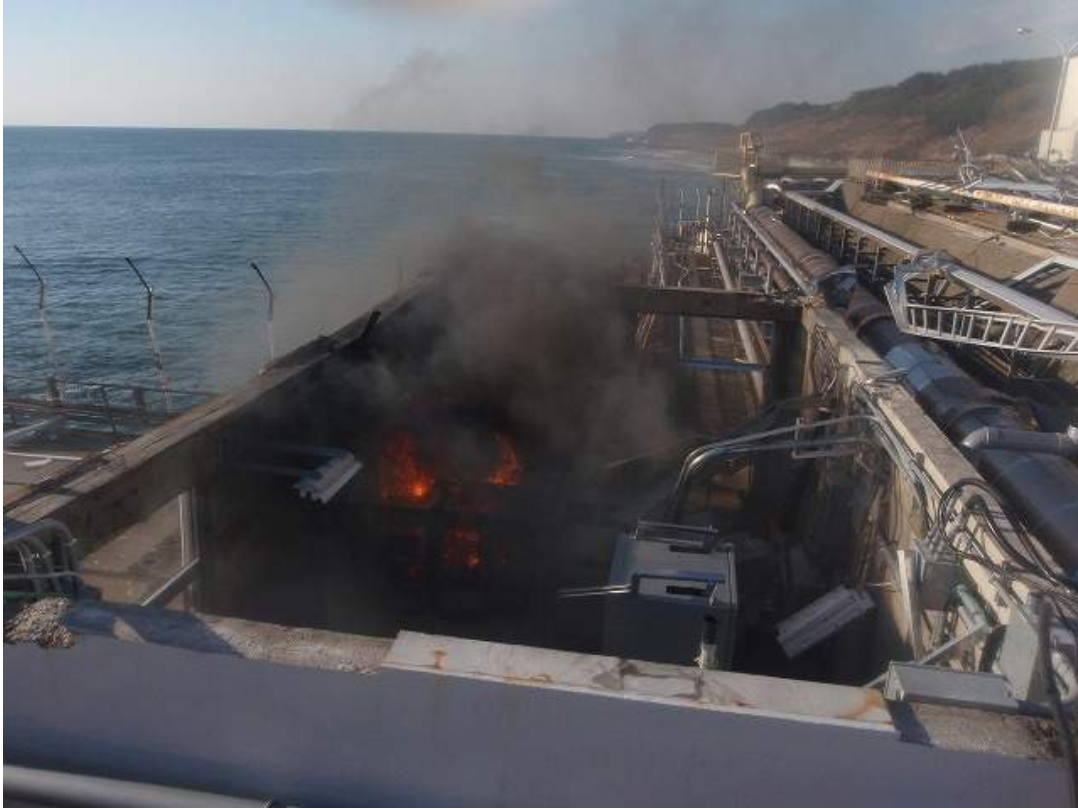
Fig. 136. Unité 1 et 4 avec l'explosion © Tepco
