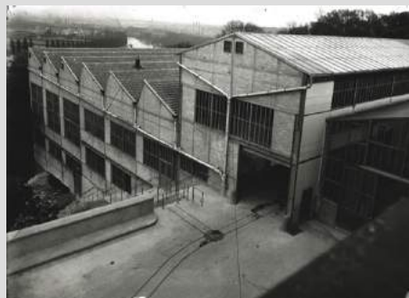
Fig. 63. Entrée de la station d'essais, travée 4, sur le site de l'Office national des recherches scientifiques et industrielles et des inventions à Bellevue, Meudon, le 15 juin 1931. © CNRS Photothèque/Fonds historique
