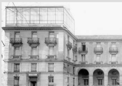
Fig. 59. Détail de la verrière de l'atelier de photographie et de cinématographie sur la terrasse de l'aile Nord du Pavillon, Mars 1922 © CNRS Photothèque/Fonds historique
