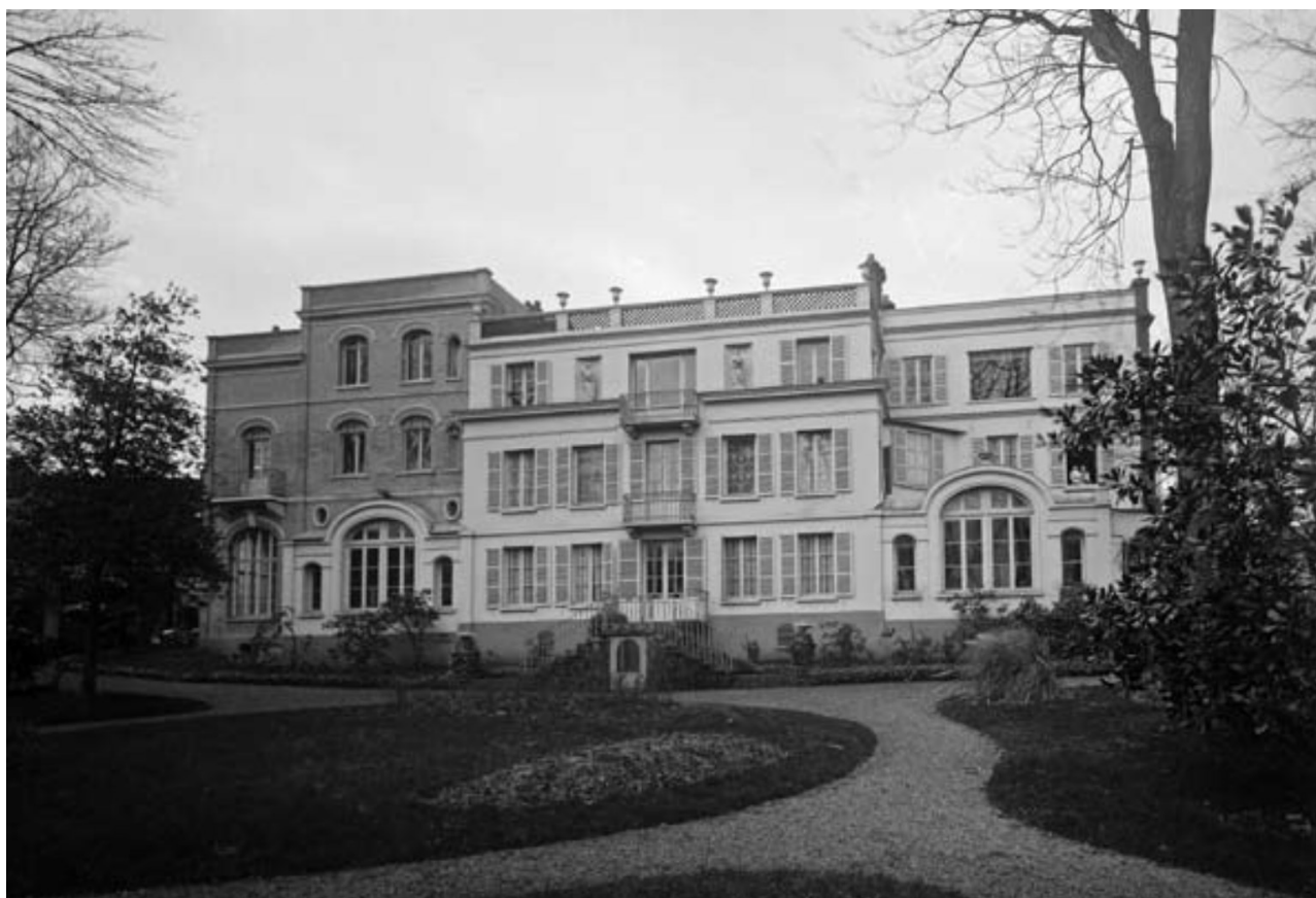
Figure 34 : Villa des roses côté jardin. Coll. Archives départementales de l'Oise, 5 Fi 889, cliché Charles Commesy.
