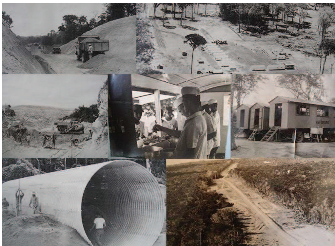
Fotografia 1 - Construção da Br-163 – Trecho Cuiabá (MT)-Santarém (PA)
