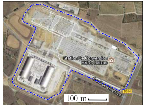
(b) INELFE : MMC, 2 \times 1000 MW, \pm 320 kV
