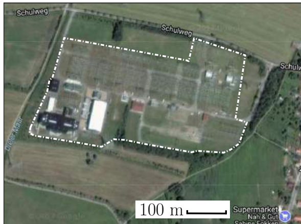
(a) BorWin1 : 2-level VSC, 400 MW, \pm 150 kV
