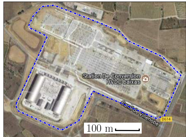
(b) INELFE : MMC, 2 \times 1000 MW, \pm 320 kV
