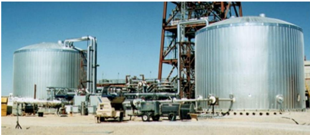
Figure 29. Exemple de cuve de stockage. Ici, deux cuves de stockage de sels fondus [50].
