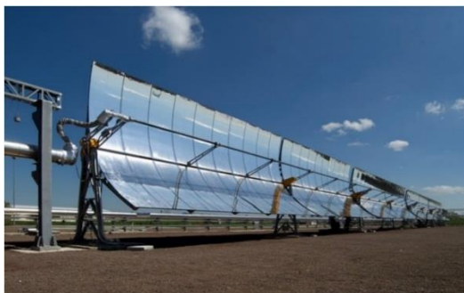
Figure 18. Concentrateur solaire cylindro-parabolique [21].
