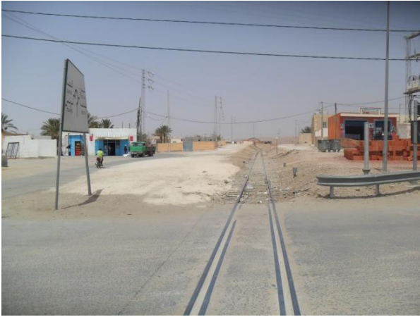
10.3. Servitude de ligne ferroviaire, on isolement des cités
