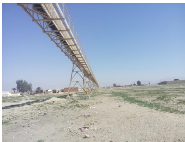
13.2. Rail transporteur de phosphate
