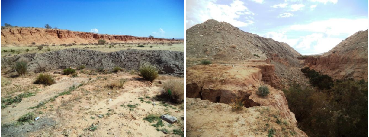
Photos 15.4. et 15.5. : Tas de stériles placés dans le réseau hydrographiques
