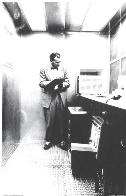
**Figure 1 : La première salle à flux laminaire construite par Sandia corporation (Source : [www.ultraproprete.com](http://www.ultraproprete.com))**
