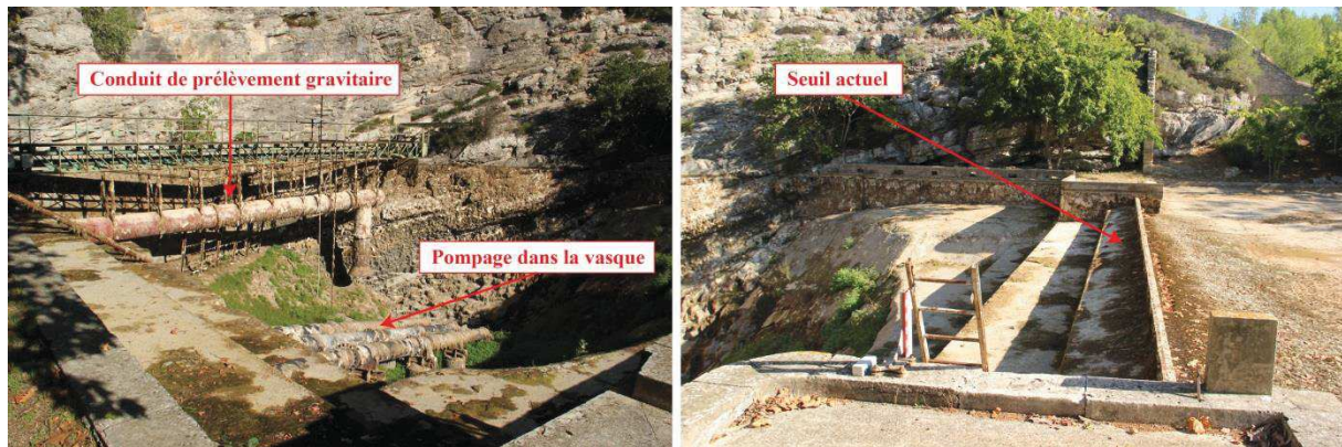
Figure 20 : Observation des aménagements de la source du Lez asséchée par les pompages effectués en amont de la source (septembre 2013).
