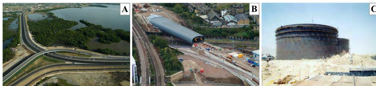
Figure 1.1 Illustrations de réalisations notables : A - projet « Highway 2000 » ( www.h2k-jio.com ), B - projet « Channel Tunnel Rail Link » ( www.fcp.at ) et C - la centrale électrique « Suez Gulf Power Plant » ( www.menard-vibro.ae ).
