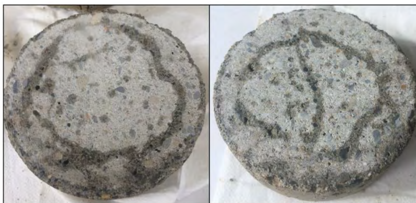
Figure 2.45 Illustration du réseau de fissures interne du mortier CEM I à la fin de l'essai d'attaque sulfatique
