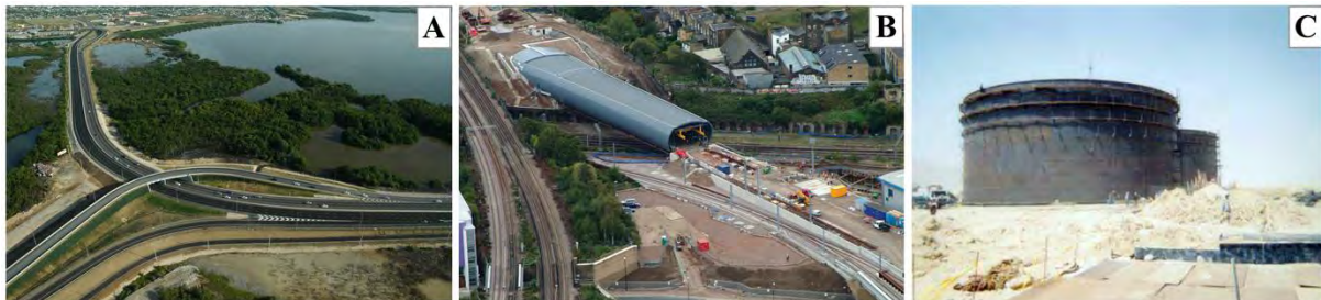
Figure 1.1 Illustrations de réalisations notables : A - projet « Highway 2000 » ( www.h2k-jio.com ), B - projet « Channel Tunnel Rail Link » ( www.fcp.at ) et C - la centrale électrique « Suez Gulf Power Plant » ( www.menard-vibro.ae ).
