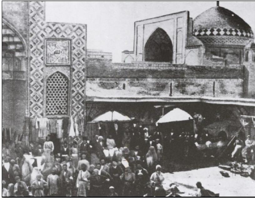
Figure 6 : Face avant de la mosquée de l'Imam, Gazvin (années 1930)
