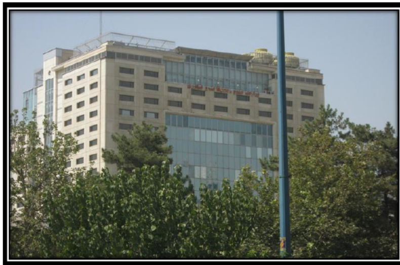
Figure 30 : Shahrak-e-Gharb, le ministère de l’Enseignement supérieur et de la Recherche
