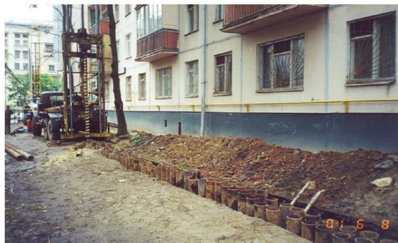
Figure IV-6 Installation de la paroi de protection réalisée en tranchée ouverte composée de tubes d'acier. 61/67, Pochtovaya Str. à Moscow. Nikiforova, N. S. et al., (2012)
