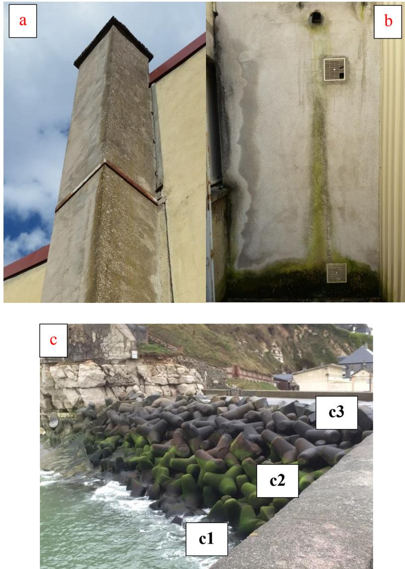
Figure I-15 : Exemple de l'influence des paramètres du milieu sur la colonisation microbienne
