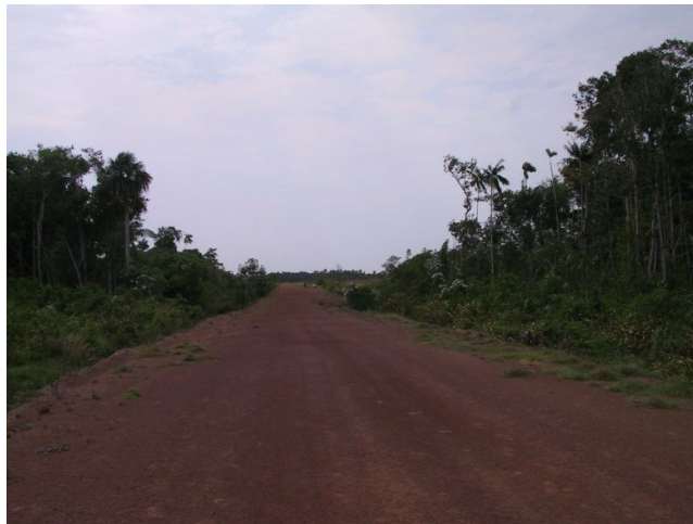
Fig. 101 Photo de Cimarron, voies internes. Prise par l'auteur. 2014
