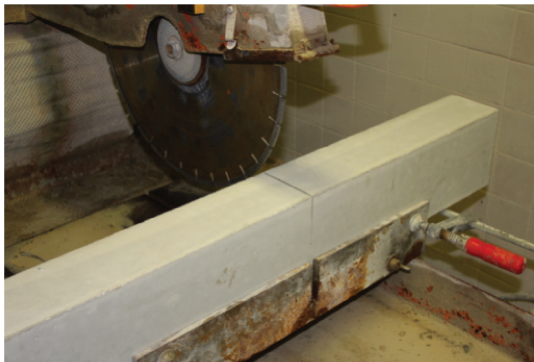
(a) Mise en place et fixation de la poutre
