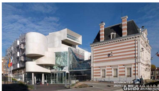
Fig. 53. Vue extérieure de l'hôtel de ville de Bagnolet
