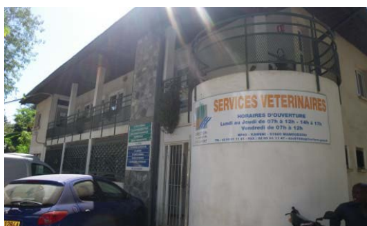
Photo 1. Locaux du service de l'alimentation à Kawéni (Source : Defernez, Cardinale, et Girard 2010)
