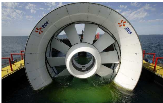
c) Hydrolienne (site de Paimpol-Bréhat)
