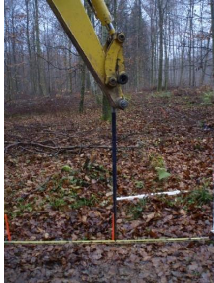
Photographie 14 – Sondage à la pelleuse en vue la détermination de la profondeur d'apparition de la roche-mère calcaire (site expérimental de Montiers).
