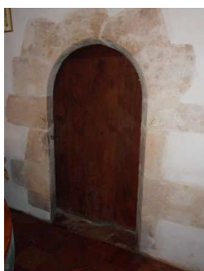
Figure 301 : Porte biaise à Planchette à Cormes
