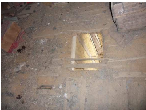
Figure 123 : Plancher de l'étage à La Bondonnière à Montfort-le-Gesnois
