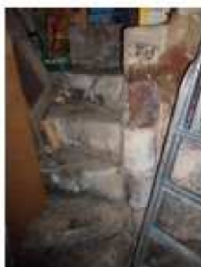
Figure 272 : Accès intérieur à la cave de la Vacherie à La Ferté-Bernard
