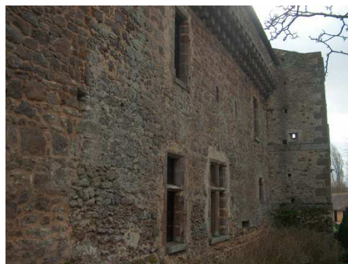
Figure 603 : Le Vieux Lavardin à Mézières-sous-Lavardin
