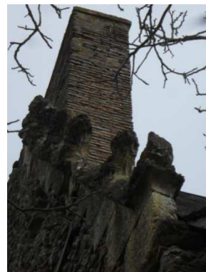
Figure 194 : Détail des crochets à La Chevalerie à Sainte-Cérotte
