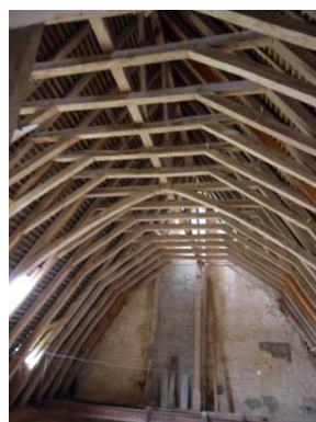
Figure 171 : Charpente de La Garenne à Roullée
