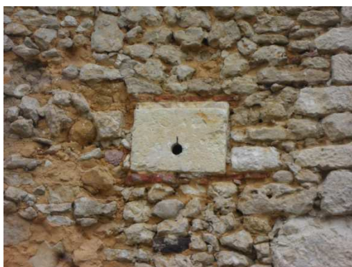
Figure 95 : Moellons de pierres à La Grande Mérie à Courgenard
