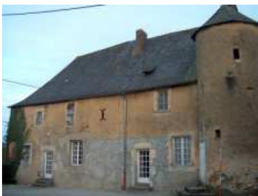
Figure 254 : Façade avant de La Brochère à Rouez-en-Champagne
