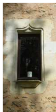
Figure 224 : La Grande Roche à Souvigné-sur-Même
