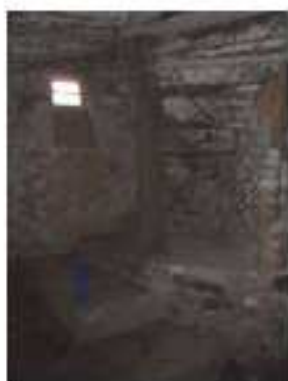
Figure 271 : Accès intérieur à la cave de la Hollière à Bonnétable
