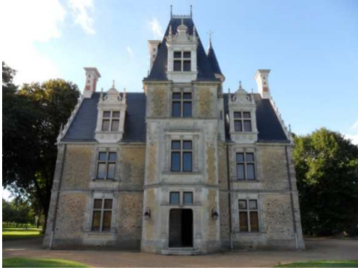
Figure 3 : Bois Doublet, extérieur du logis
