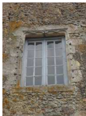
Figure 236 : Planche à Saint-Rémy-des-Monts
