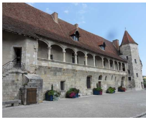
Figure 716 : Château de Nérac
