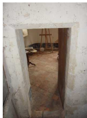
Figure 257 : Petite chambre de la tour de La Garenne à Roullée
