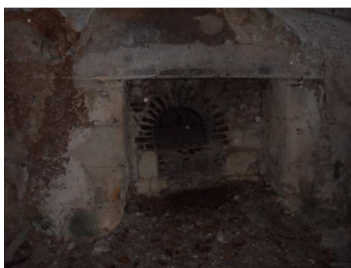
Figure 295 : Cheminée dans l'une des caves troglodytes de La Béchuère à Saint-Gervais-de-Vic
