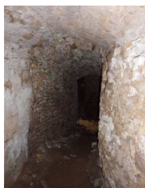
Figure 292 : Tunnel dans la cave de Maridort à Bourg-le-Roi
