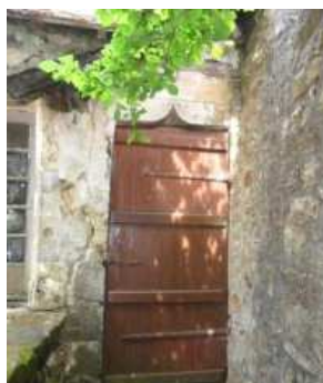
Figure 633 : Le Logis à Montreuil-le-Chétif
