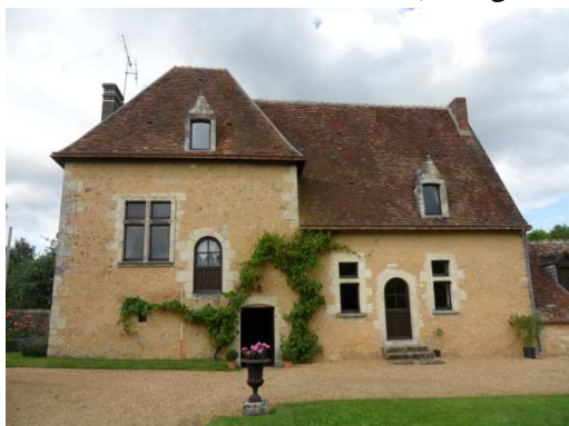
Figure 267 : La Grande Roche à Souvigné-sur-Même
