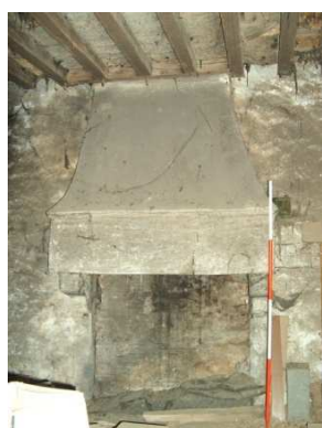
Figure 384 : Radray à Assé-le-Riboul
