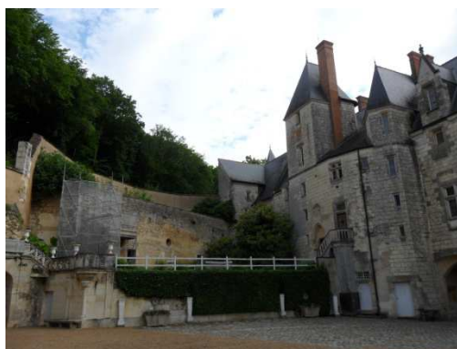
Figure 315 : Second logis à Courtanvaux avec vestiges de la galerie
