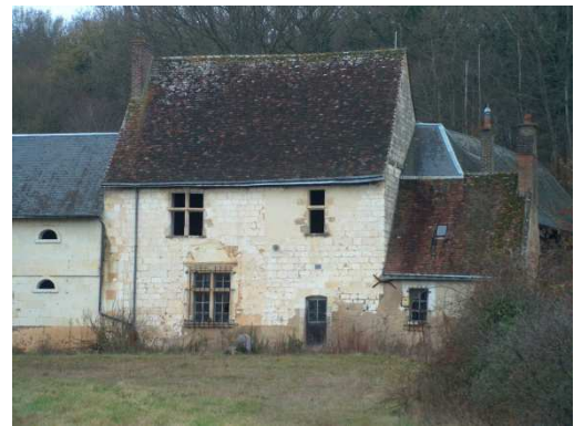
Figure 100 : Pierre de tuffeau à Romigny à Bessé-sur-Braye
