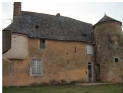
Figure 255 : Façade arrière de La Brochère à Rouez-en-Champagne
