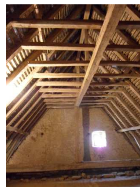
Figure 172 : Charpente du Logis à Thoigné
