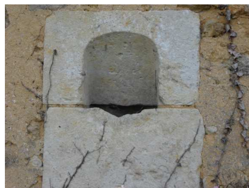
Figure 285 : La Pinelière à Gréez-sur-Roc
