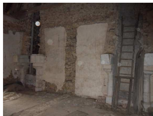
Figure 324 : Les deux petites salles à feu à La Chevalerie à Sainte-Cérotte
