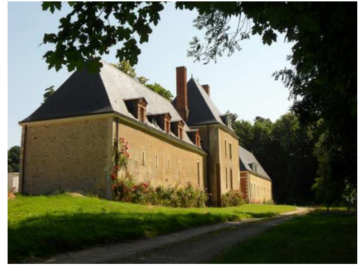
Figure 105 : Façade arrière du pavillon au château du Cogners
