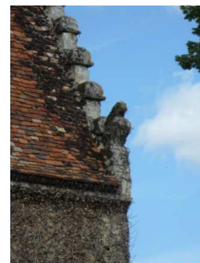
Figure 493 : La Pinelière à Gréez-sur-Roc
