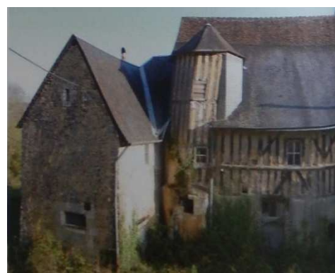
Figure 115 : Romigny à Bessé-sur-Braye
