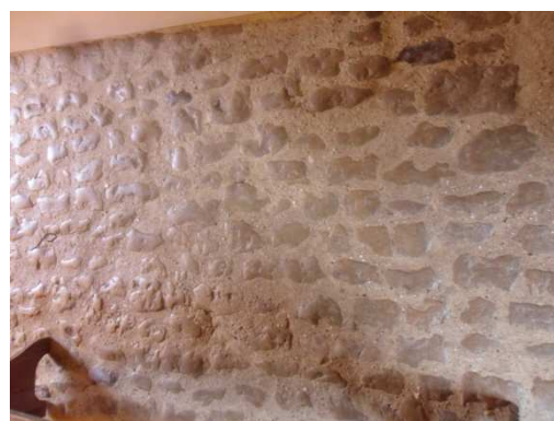
Figure 152 : Pavage en pierre à La Grande Mérie à Courgenard
