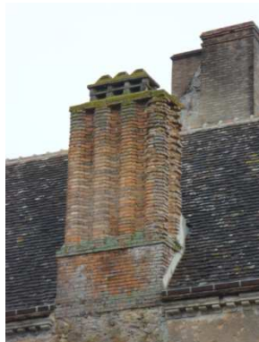
Figure 106 : Souche de cheminée à Planchette à Cormes
