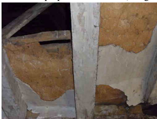
Figure 125 : Plafond à La Bondonnière à Montfort-le-Gesnois
