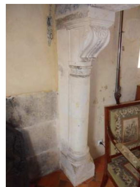
Figure 421 : La Roche à Souvigné-sur-Même
