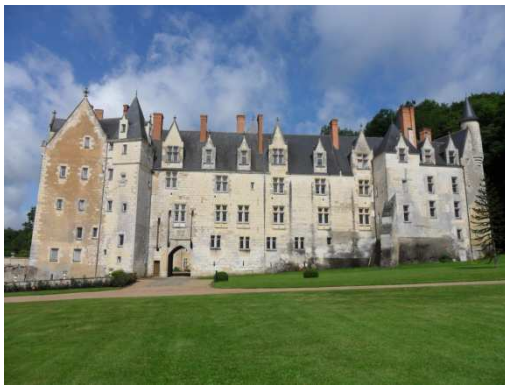
Figure 99 : Pierre de tuffeau à Courtanvaux à Bessé-sur-Braye
