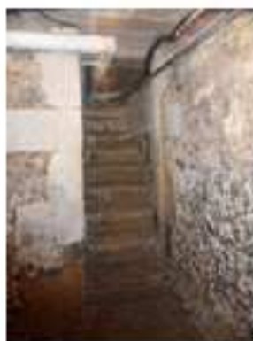
Figure 277 : Accès intérieur à la cave à La Chevalerie à Sainte-Cérotte
