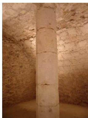
Figure 289 : Pilier dans la salle voûtée du Château de Bouloire
