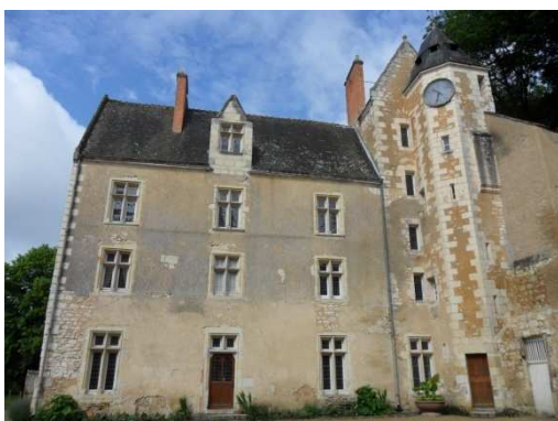
Figure 33 : Logis de 1455 à Courtanvaux à Bessé-sur-Braye
