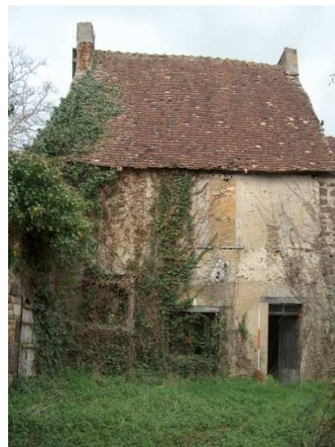
Figure 27 : Logis du XVe siècle, Le Vieux Château à Juillé
