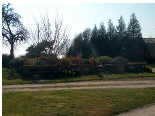
Figure 529 : Vestiges de la fuie de Salaines à Crissé
