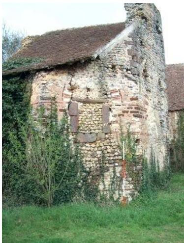
Figure 26 : Tour gallo-romaine au Vieux Château à Juillé
