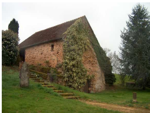
Figure 269 : Cave à Vaulahard à Domfront-en-Champagne
