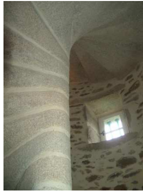
Figure 330 : La Chapelle à Arçonnay
