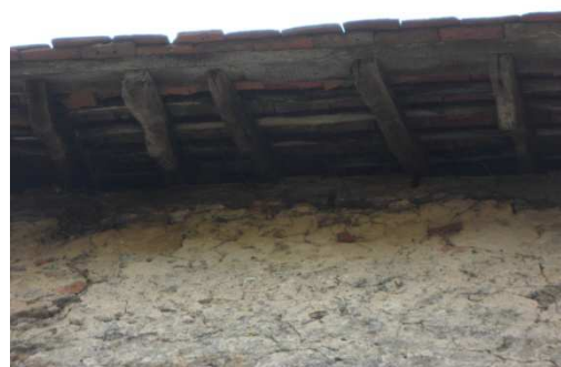
Figure 188 : Coyeaux à La Salle à Bouër
