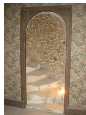
Figure 363 : Verdigné à Avesnes-en-Saosnois
