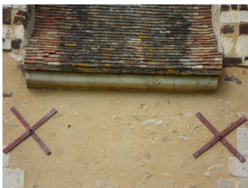
Figure 189 : Corniche à Buis à Saint-Célerin
