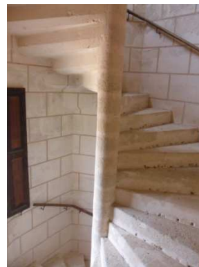
Figure 347 : Petit escalier de Courtanvaux à Bessé-sur-Braye
