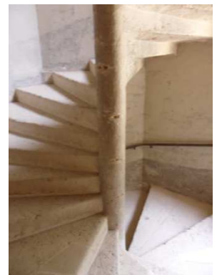
Figure 348 : Grand escalier de Courtanvaux à Bessé-sur-Braye
