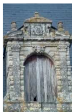
Figure 233 : Verdigné à Avesnes-en- Saosnois
