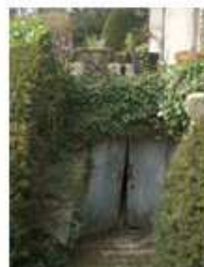
Figure 274 : Accès extérieur à la cave du Château de Saint-Paterne
