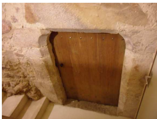
Figure 288 : Entrée de la cave voûtée du Château de Bouloire
