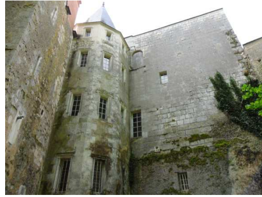
Figure 92 : Courtanvaux à Bessé-sur-Braye
