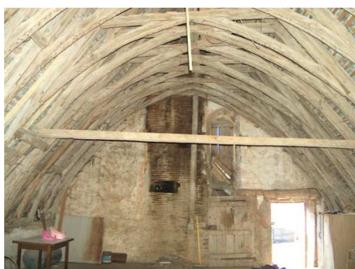
Figure 170 : Berceau en arc brisé à L'Épinay à Saint-Marceau
