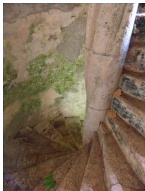
Figure 337 : Courtanvaux à Bessé-sur-Braye
