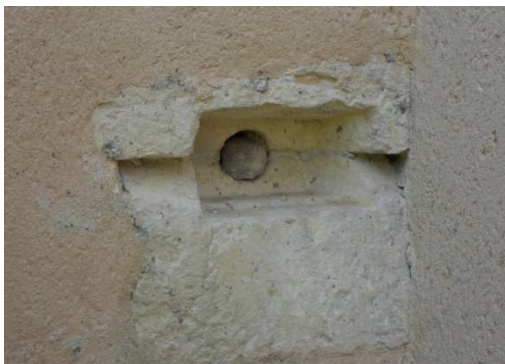
Figure 582 : La Roche à Villaines-la-Gosnaie
