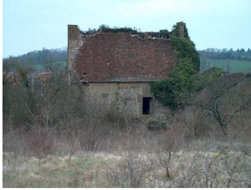
Figure 13 : Façade sud de La Vacherie à Vivoin
