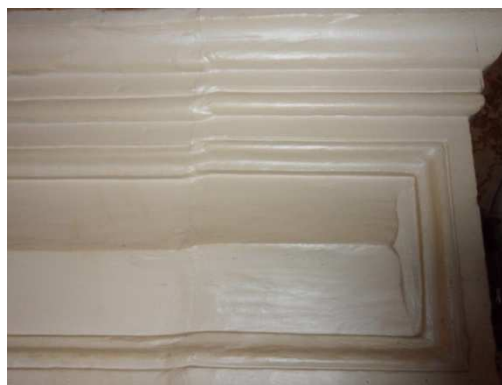
Figure 719 : Maison du Grand Chardon à Montfort-le-Gesnois
