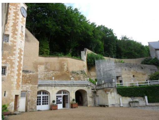
Figure 314 : Ancien logis de Courtanvaux avec vestiges de la galerie au dessus des salles creusées dans la roche
