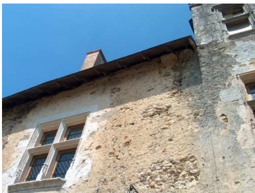
Figure 187 : Coyeaux à l'Échenay à Assé-le-Boisne
