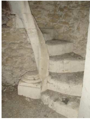
Figure 341 : Escalier du pavillon à Verdigné à Avesnes-en-Saosnois
