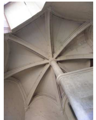
Figure 336 : Courtanvaux à Bessé-sur-Braye
