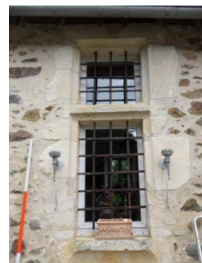
Figure 110 : Ouverture à Lévrigné à Assé-le-Boisne
