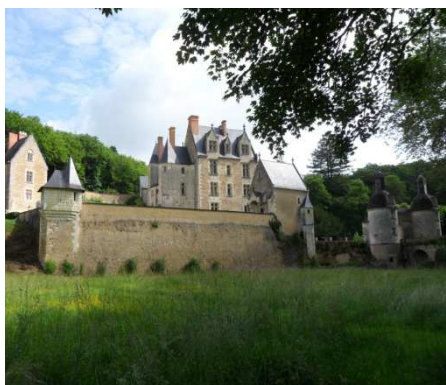
Figure 536 : Courtanvaux à Bessé-sur-Braye
