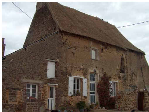
Figure 258 : La Coutoudière à Assé-le-Riboul
