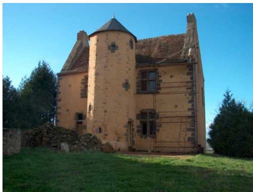
Figure 265 : Façade avant de La Corbinière à Mézières-sous-Lavardin
