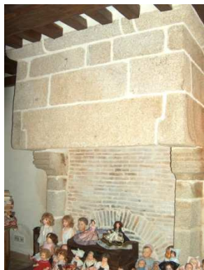
Figure 132 : La Chapelle à Arçonnay
