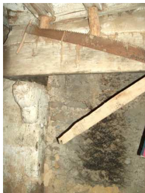
Figure 411 : La Coutoudière à Assé-le-Riboul
