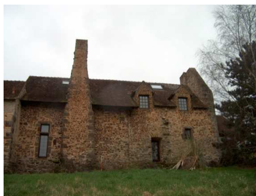
Figure 36 : Façade arrière de Vaulahard à Domfront-en-Champagne
