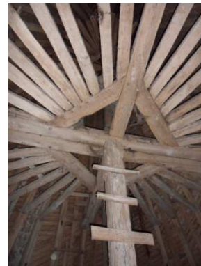
Figure 184 : Enrayure à Chéronne à Tuffé
