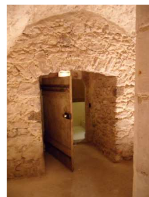
Figure 290 : Salle voûtée du Château de Bouloire
