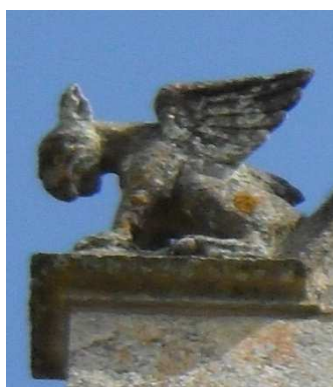
Figure 663 : Courtanvaux à Bessé-sur-Braye
