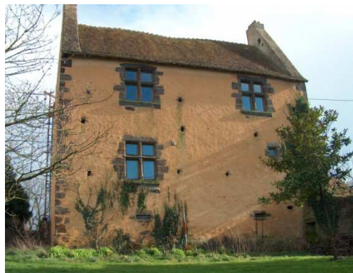
Figure 266 : Façade arrière de La Corbinière à Mézières-sous-Lavardin
