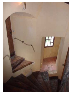
Figure 300: Tour d'escalier de La Garenne à Roullée
