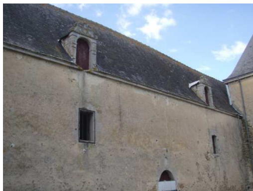
Figure 311 : Extérieur de la galerie de Verdigné à Avesnes-en-Saosnois
