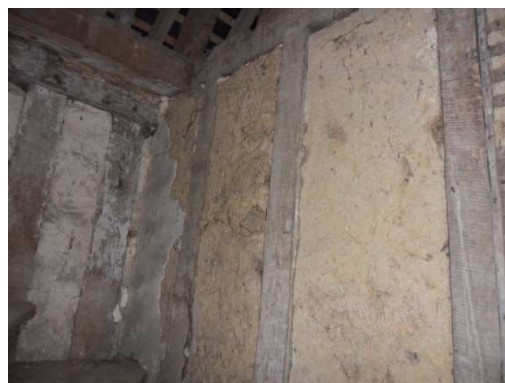
Figure 124 : Cloisons à La Bondonnière à Montfort-le-Gesnois
