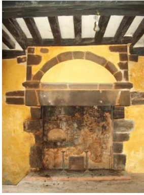
Figure 372 : La Corbinière à Mézières-sous-Lavardin
