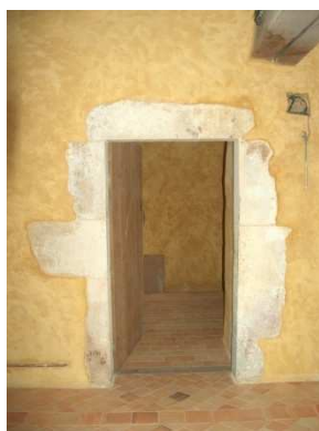
Figure 325 : Cabinet au rez-de-chaussée donnant dans la cuisine à La Cour de Coudrecieux
