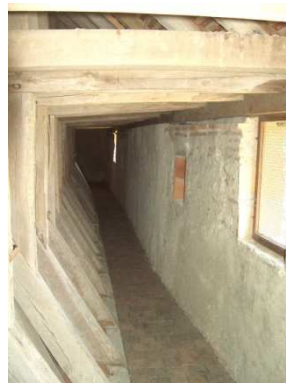
Figure 606 : Château de Bouloire
