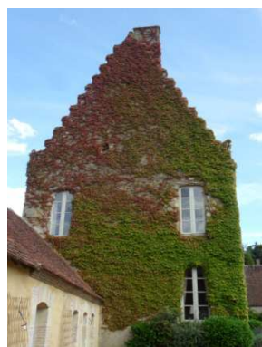
Figure 193 : La Pinelière à Greez-sur-Roc
