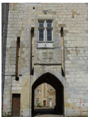
Figure 550 : Château de Courtanvaux, vestiges du pont-levis
