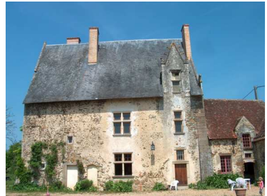
Figure 107 : Souches des cheminées de L'Échenay à Assé-le-Boisne
