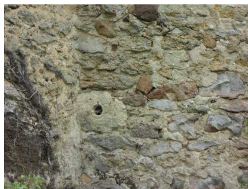
Figure 96 : Moellons de pierres à Buis à Saint-Célerin
