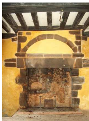
Figure 134 : La Corbinière à Mézières-sous-Lavardin
