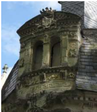
Figure 501 : Courtanvaux à Bessé-sur-Braye
