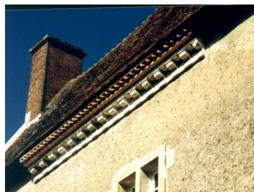
Figure 190 : Corniche à modillons à La Cour de Coudrecieux
