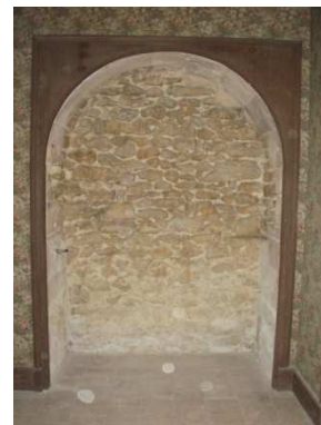
Figure 457 : Verdigné à Avesnes-en-Saosnois
