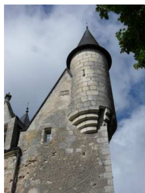
Figure 593: Courtanvaux à Bessé-sur-Braye
