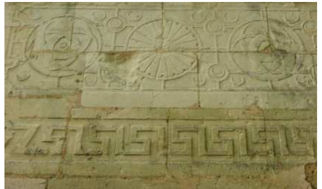
Figure 503 : Courtanvaux à Bessé-sur-Braye
