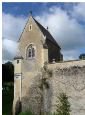
Figure 507 : Courtanvaux à Bessé-sur-Braye
