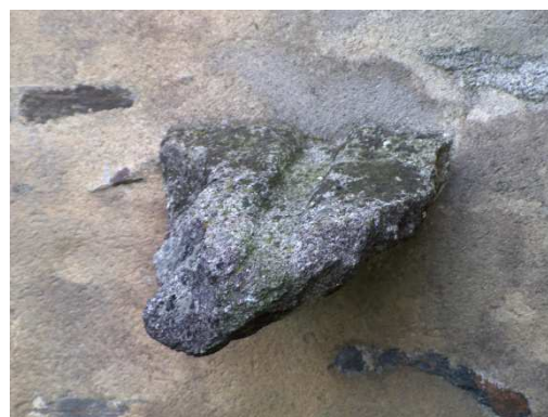
Figure 464 : La Chapelle à Arçonnay
