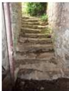
Figure 276 : Accès extérieur à la cave à Buis à Saint-Célerin
