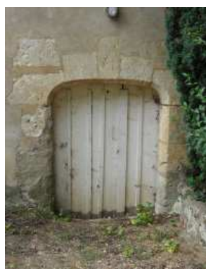
Figure 244 : La Pinelière à Greez-sur-Roc
