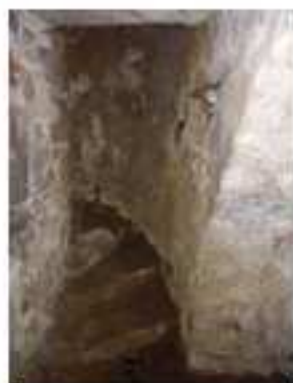
Figure 275 : Accès intérieur à la cave à Buis à Saint-Célerin
