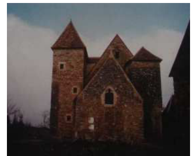
Photographie de février 1994 (pignon sud)
