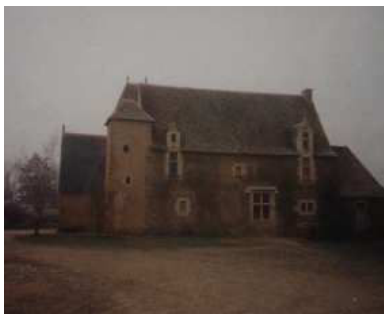
Photographie de janvier 1995 (façade ouest)
