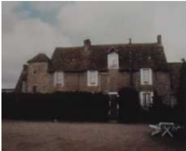
Photographie de mai 1991 (façade ouest)
