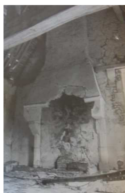
Cheminée de la chambre
