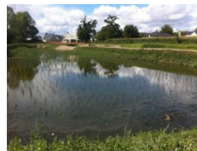
(b) Filtre planté de roseaux en eau à Lamballe (22) (Photo : SINBIO)
