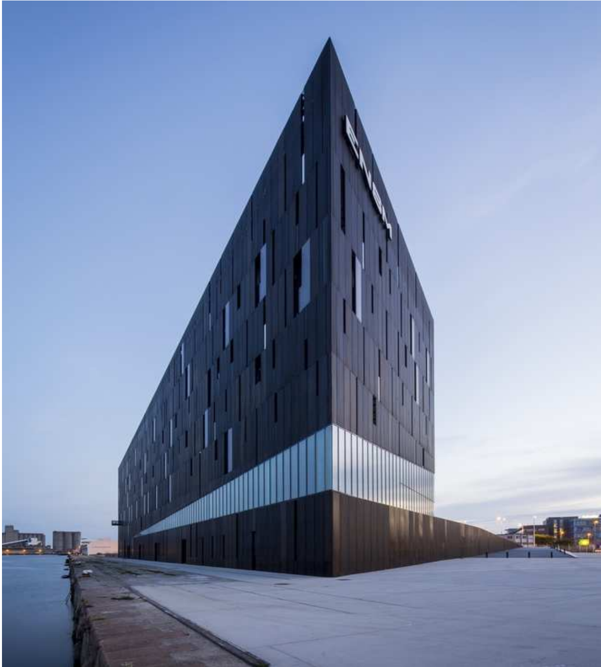
Fig. 51 : L'École nationale supérieure de la marine, 2015, AIA architectes – Photo DR
