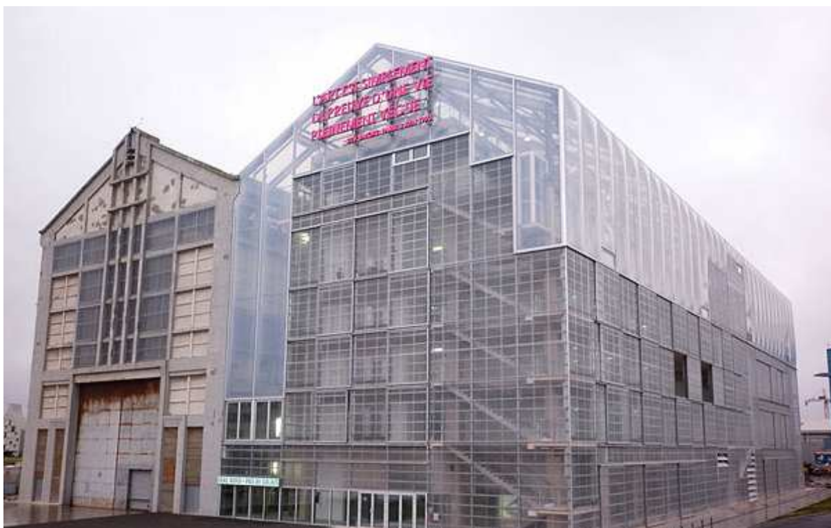
Fig. 22 : Fonds régional d'art contemporain à Dunkerque : la halle industrielle d'origine (à g.) a été dédoublée par un second bâtiment neuf © Lacaton et Vassal architectes – Photo DR
