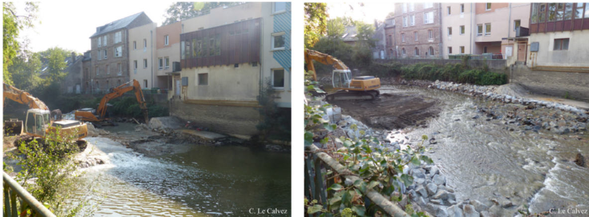
A. Début des travaux au déversoir de Carcé (Bruz) - 2015 Phase d'effacement de l'ouvrage
