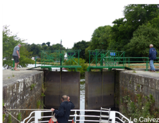
B. Passage d'une écluse (juillet 2015). Manoeuvrage manuel des portes.
