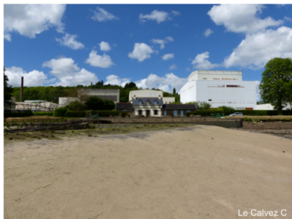
Ecluse de Coatigrac'h à sec. Photographie prise depuis le barrage, le 20 mai 2014
