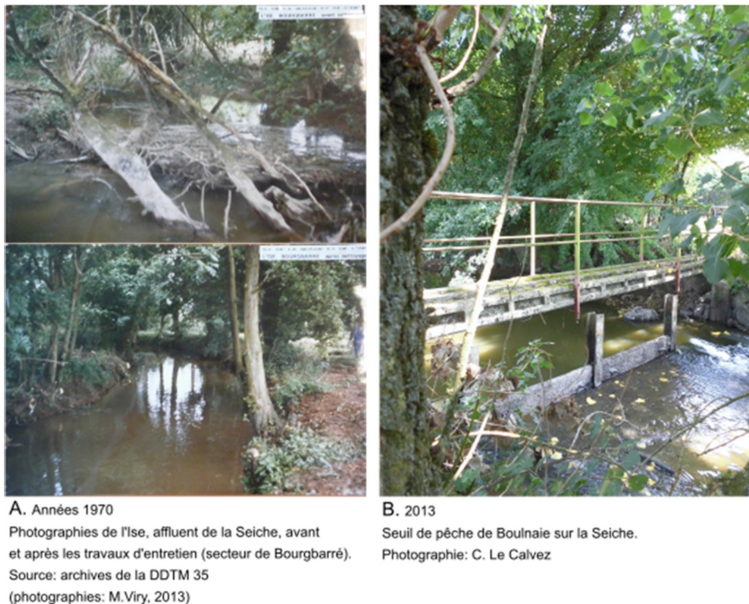
Figure 26 - Entretien et aménagements effectués dans la seconde moitié du 20 ème siècle.
