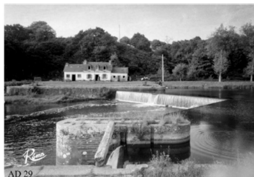
B. Canal de Nantes à Brest: écluse de Prat-Pourric dans les années 1950 (Finistère).
