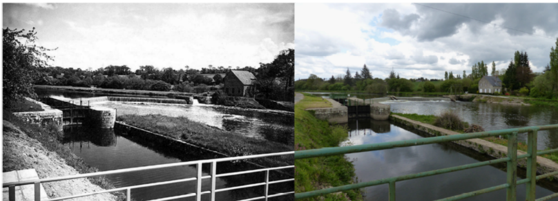
Planche 9 : écluse de Goaker.
