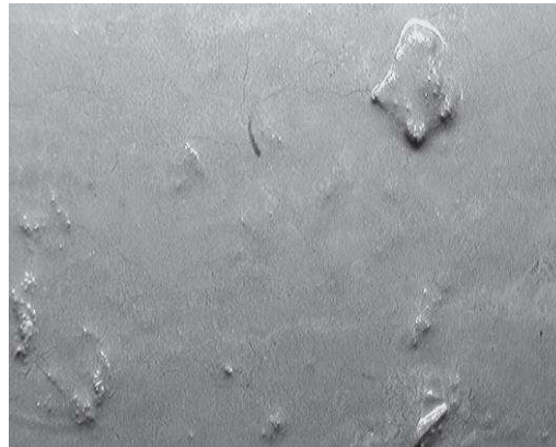
Figure 3- 3 : pellicule d'eau ressuee en surface du béton B100R1,2A, essai du 02 avril 2014.
