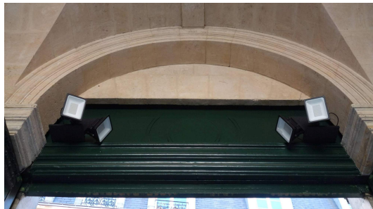
Portail sur rue, vu du passage cocher
