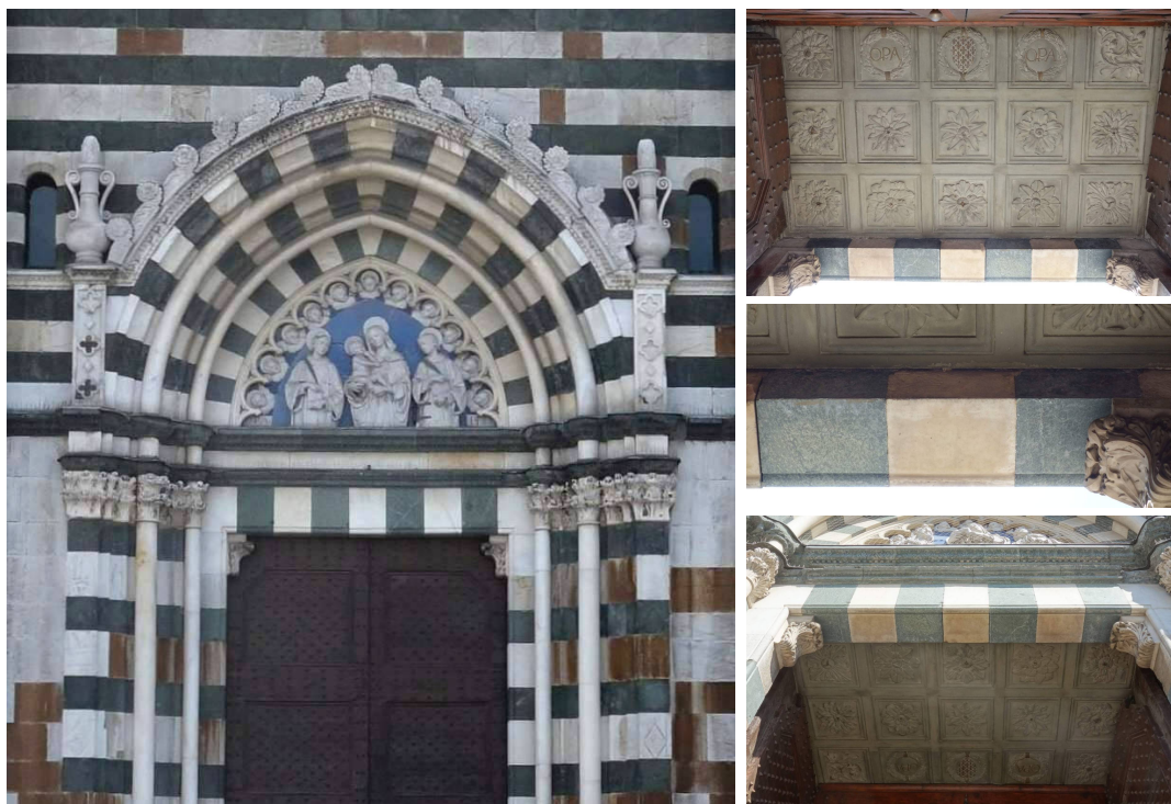
Fig 8.8 – Plate-bande à joints en fausse-coupe, portail occidental de la cathédrale de Prato
