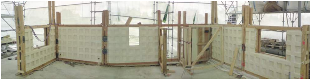
Fig E.1 – Mur horizontal construit suivant le principe des voûtes d'Abeille, d'après Brocato et al. (2014)
