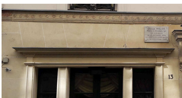
Fig 6.7 – Faux-appareil d'une plate-bande dessinée sur enduit, 13 rue des Beaux-Arts à Paris et 72 rue Saint-Louis-en-L'Île à Paris
