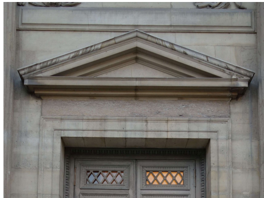
Plate-bande en fausse-coupe de Lemerrier (1639-1642)
