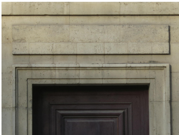
Fig 8.7 – Plate-bande à joints verticaux et crossettes, chapelle Saint-Louis de l'hôpital de la Salpêtrière à Paris, construite par Libéral Bruand (1671-1679)
