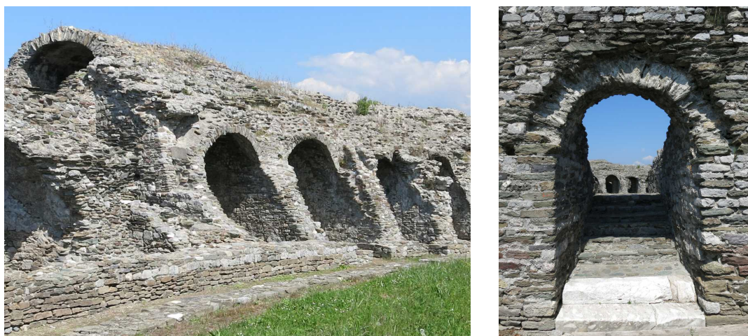
Fig 5.2 – Voûte bloquée au mortier, surmontée par une maçonnerie de blocage ; amphithéâtre de Luni, Ligurie (Italie)
