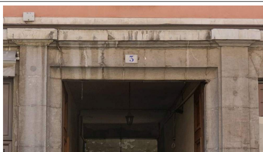
3 rue de Boigne (Façade sur rue)
