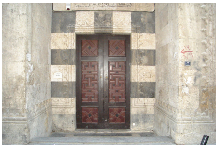
Fig 8.10 – Plate-bande à joints verticaux de la masrada 'Âdiliya à Damas (Syrie), avec crossettes masquées à l'arrière – photo : Luc Tamboréro
