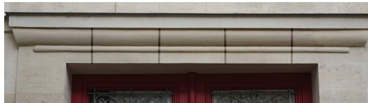
état 2017, avec surlignement des joints
