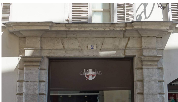
Fig 6.6 – Plate-bande à joints inclinés à inclinaison constante, et à lits brisés, 2 rue Métropole, Chambéry
