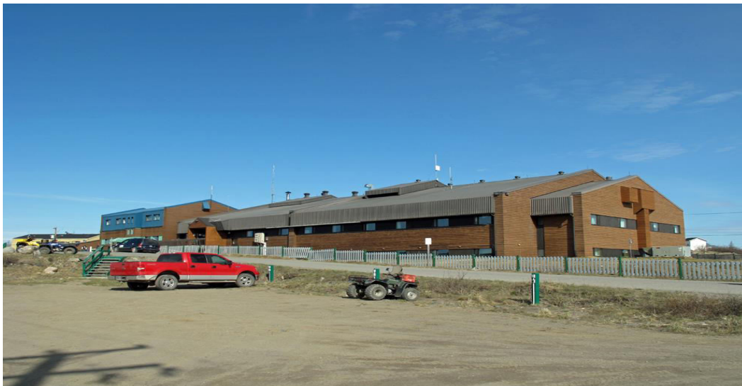
Image 8 : vue extérieure de l'hôpital Tulattavik, Kuujjuaq (©David Pinard 2009)
