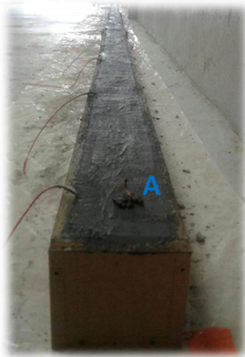
Fig.III. 5- Photo de la poutre P_{C1} après application du revêtement F_C
