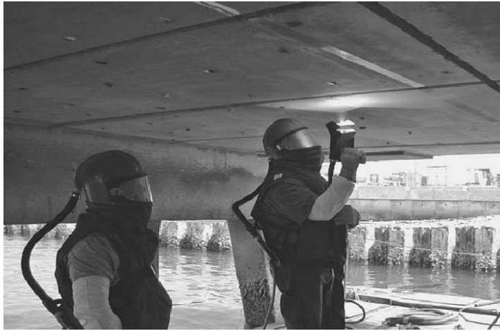
Fig.I. 26- Application du zinc projeté à chaud sur une structure en béton armé [69]
