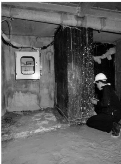
**Fig.I. 29- Application d'un revêtement électro-conducteur comme anode secondaire en PCCI [3]**
